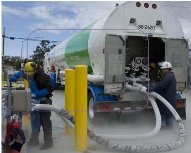
Figura 3.6 – Punto di riempimento del serbatoio da autocisterna
