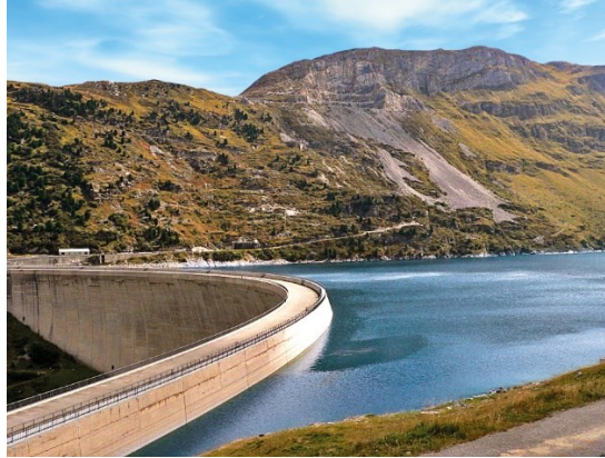
Figura 1.6 – Diga di Lei
