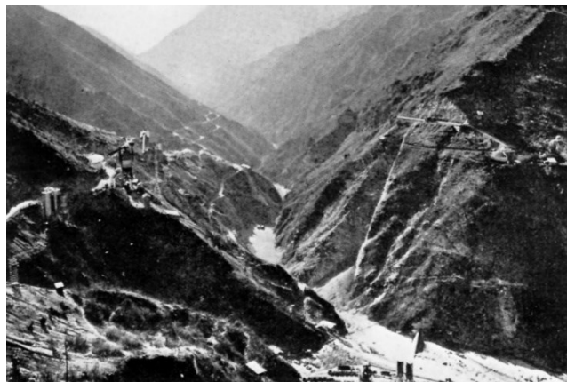
Figura 3.3.1 - Sezione d'imposta della diga nella vallata vista da monte; inizio scavi d'imposta in sponda destra
