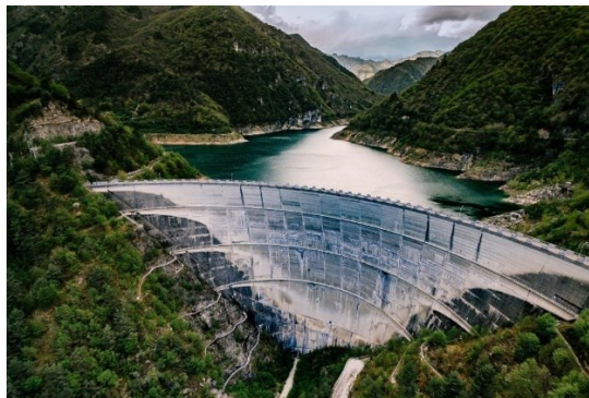
Figura 3.1.1 – Diga del Valvestino
