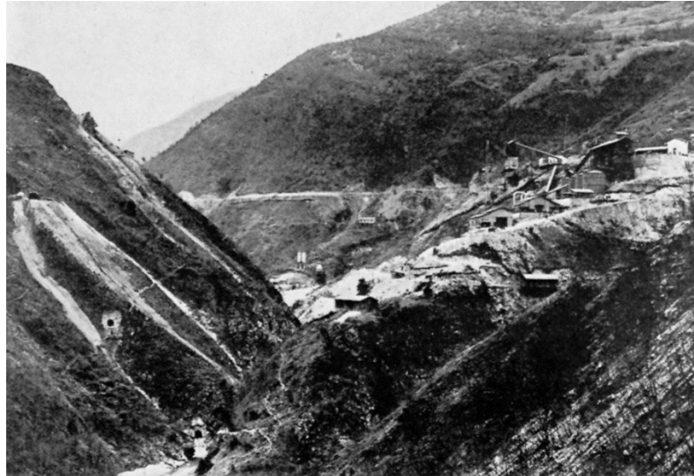
Figura 3.4.3 - Sezione d'impasto della diga vista da valle: a sinistra è possibile vedere lo scarico di superficie, lo scarico intermedio e lo scarico di fondo; a destra le installazioni di cantiere.
