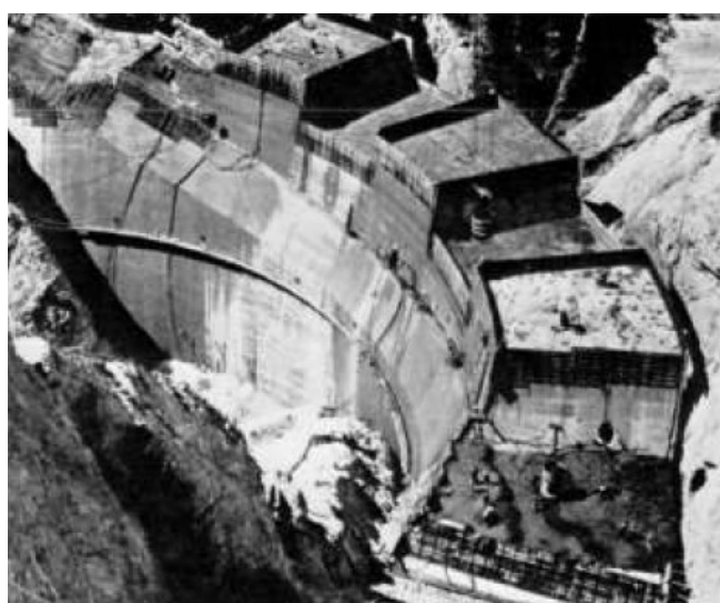
Figura 3.4.1 - Getti a conci sfalsati del tampone e del pulvino
