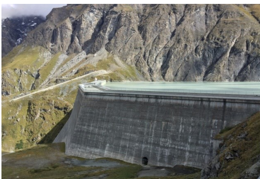
Figura 1.4 - Diga della Grande-Dixence
