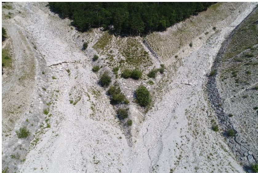
Figura 8. Confluenza dei due rami principali nella vasca di accumulo. Sono presenti tre soglie completamente sovralluvionate. (foto Martini L.)
