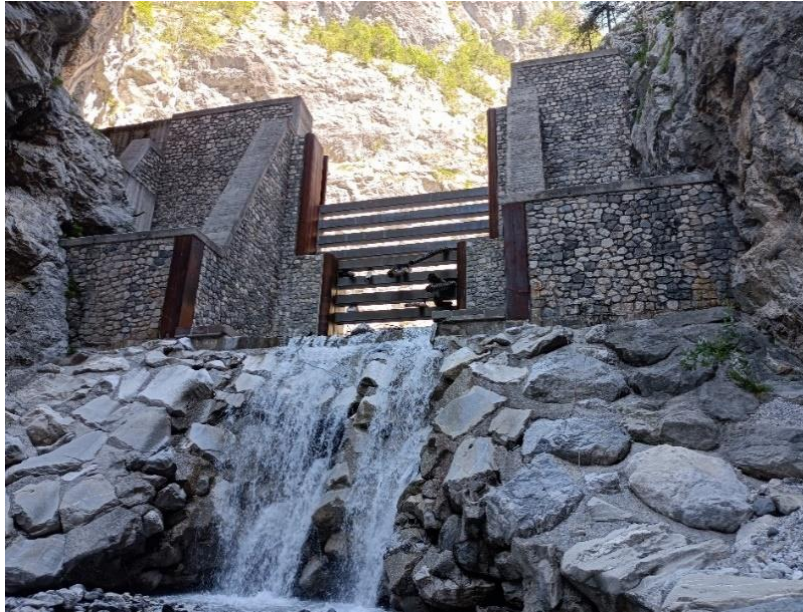
Figura 11. Briglia filtrante (Uccelli_8) in buono stato con presenza di tronchi nei filtri.
