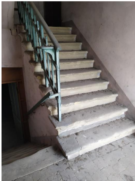
Foto 2.2.1: Scale interne al piano terra del blocco F
