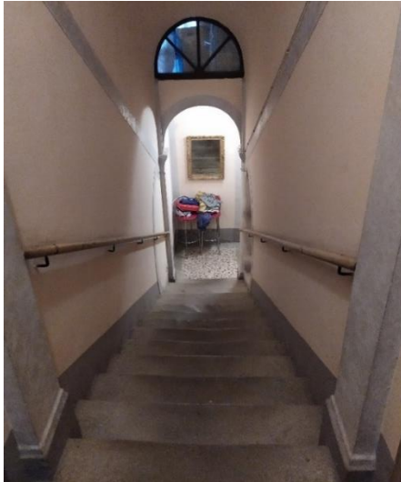
Foto 2.2.2: Scale interne al piano terra del blocco A
