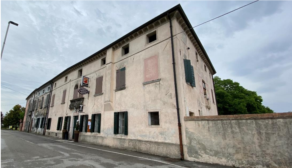
Foto 1.1.2: Prospetto nord-ovest - Stato attuale
