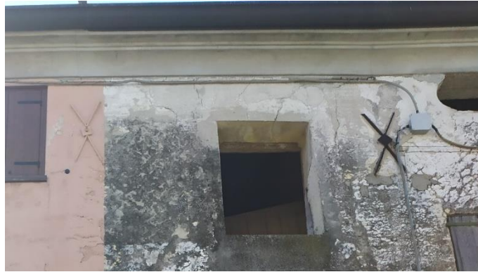
Foto 2.1.3: Esempio di tiranti metallici facciata Nord
