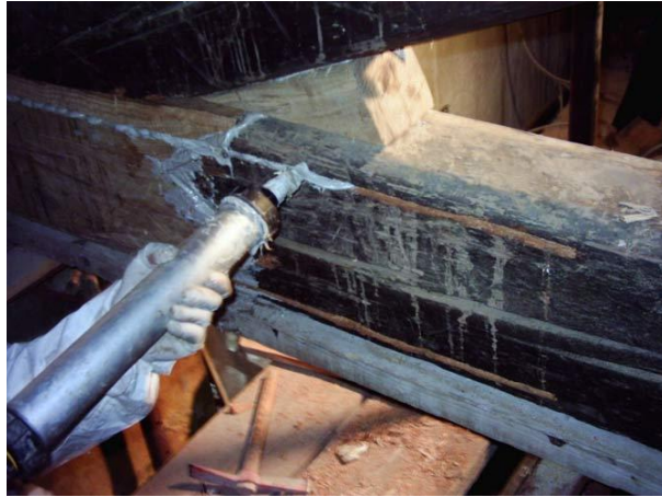
Foto 6.3.1: Esempio di stuccatura di resine epossidiche su trave lignea – Edilsystem [13]
