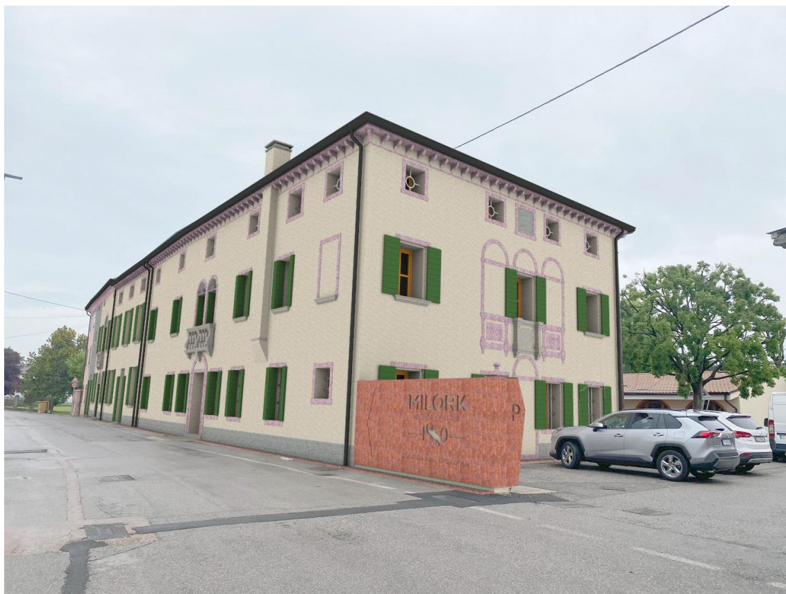
Figura 6.4.22: Foto-inserimento Prospetto Nord-Ovest - Stato di progetto
