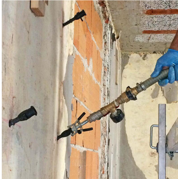
Foto 6.2.2: Esempio di iniezione di boiaccia su muratura – Yume srl [12]
