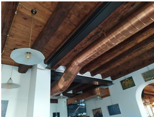
Foto 1.1.5: Solaio piano terra blocco D - Stato post-intervento
