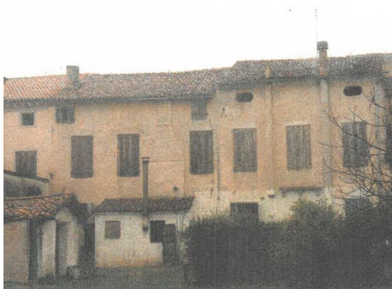
Foto 1.1.8: Prospetto Sud Stato pre-intervento
