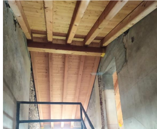
Foto 2.1.15: Esempio Copertura tipologia 2 del blocco F Stato attuale
