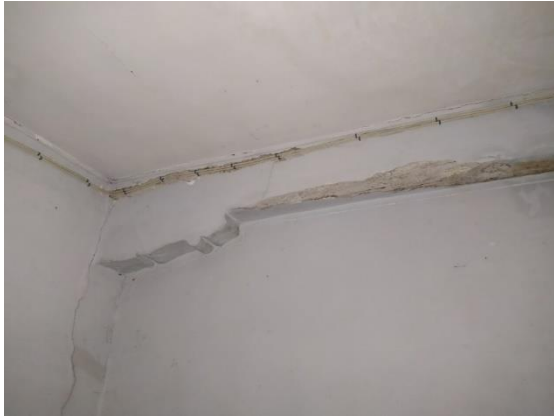
Foto 2.1.9: Trave rompitratta al piano primo del blocco D – Stato attuale
