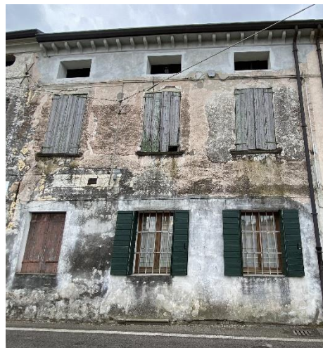
Foto 1.1.6: Prospetto Nord blocco D - Stato post-intervento
