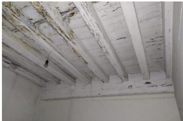
Foto 2.1.7: Esempio Solaio tipologia 2 al piano primo del blocco D – Stato attuale
