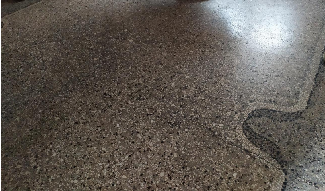
Foto 2.2.6: Pavimentazione “alla veneziana” al piano primo del blocco B Stato attuale
