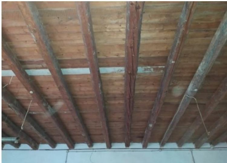
Foto 2.1.8: Esempio Solaio tipologia 3 al piano primo del blocco E – Stato attuale
