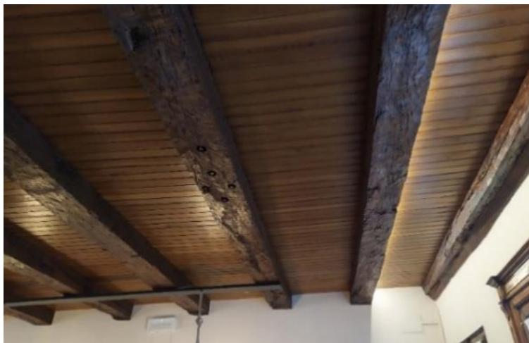
Foto 2.1.6: Esempio Solaio tipologia 1 al piano terra del blocco B – Stato attuale
