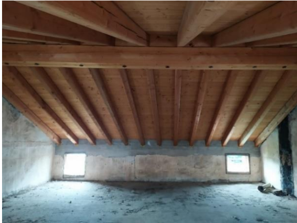
Foto 2.1.14: Esempio Copertura tipologia 2 del blocco D Stato attuale
