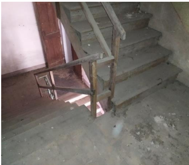
Foto 2.2.4: Scale interne al piano primo del blocco F
