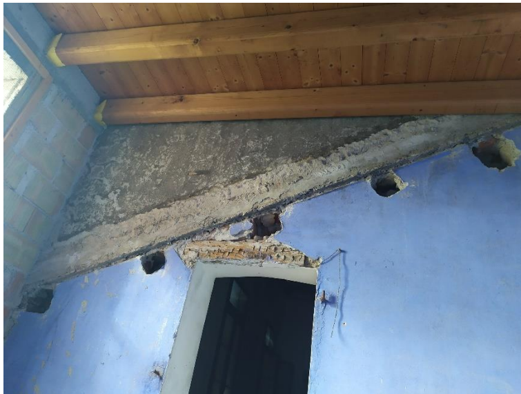
Foto 1.1.10: Segni della travatura antecedente all'intervento di modifica della copertura al blocco F Stato post-intervento
