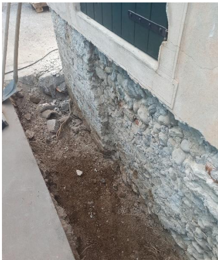
Foto 2.1.4: Tessitura muraria agli incroci tra pareti ortogonali Stato attuale
