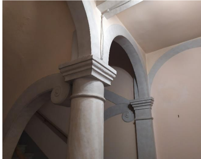
Foto 2.2.3: Particolari architettonici delle scale interne al piano terra del blocco A
