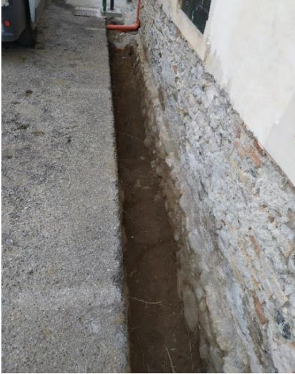
Foto 2.1.1: Fondazione tipo facciata Ovest Stato attuale
