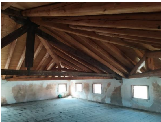
Foto 2.1.11: Esempio Copertura tipologia 1 del blocco A
