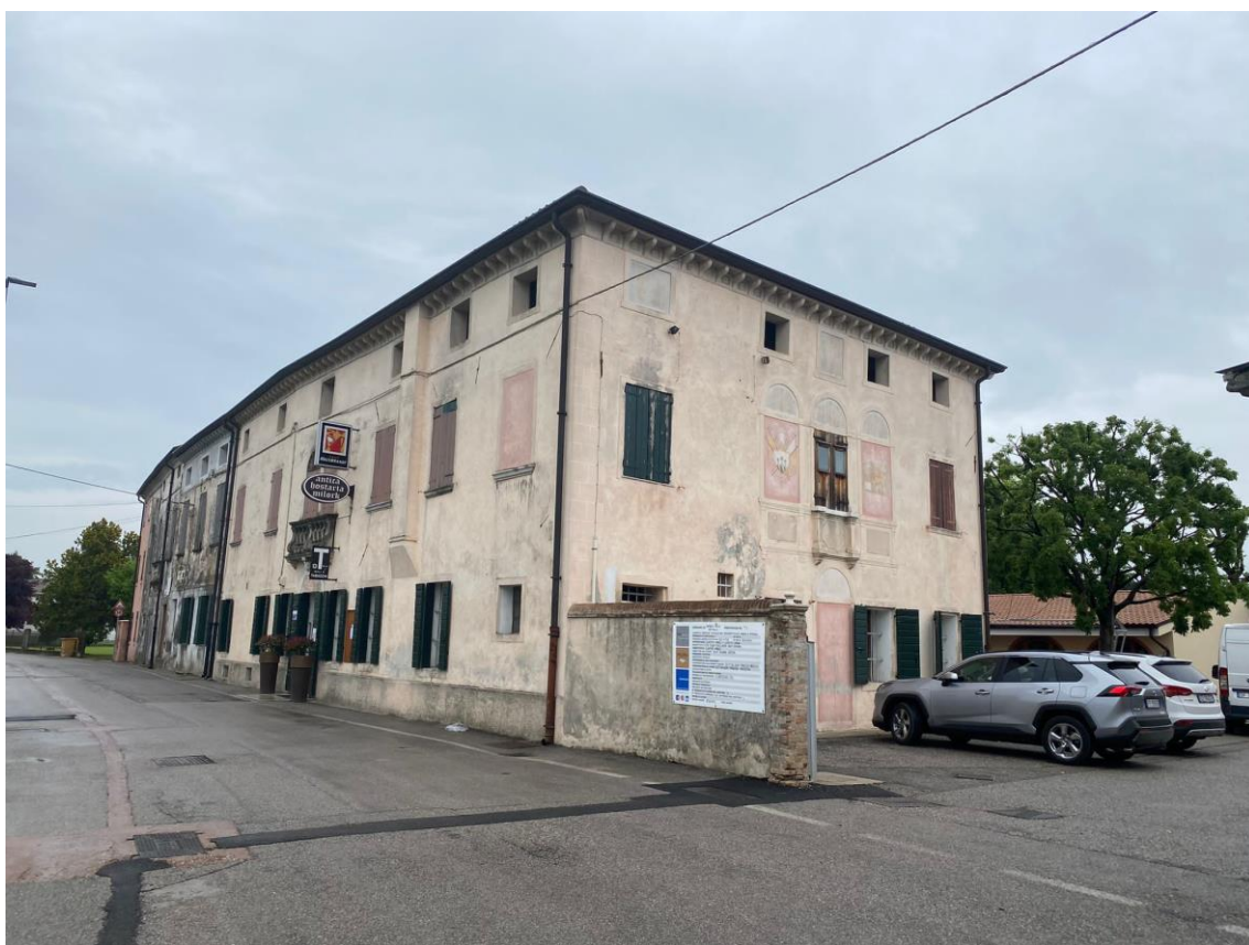
Foto 6.4.2: Prospetto Nord-Ovest – Stato attuale
