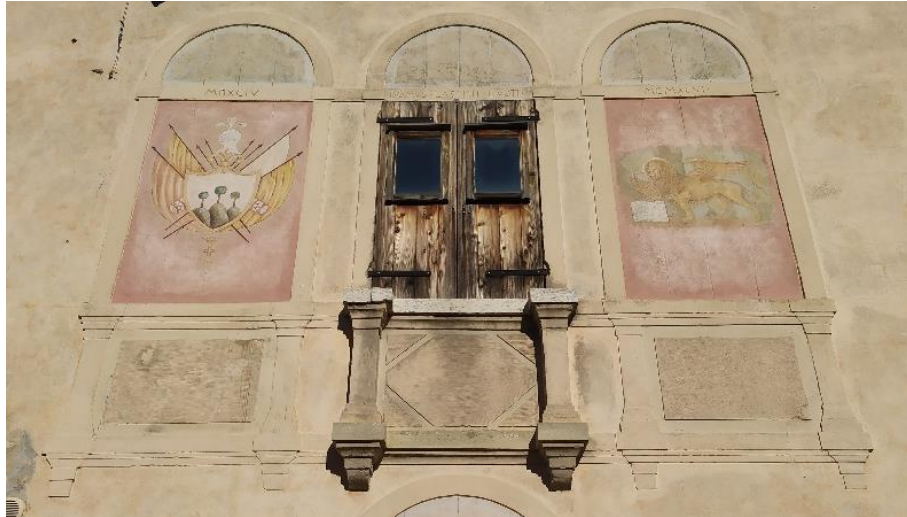
Foto 2.2.7: Balcone facciata Ovest
