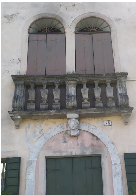
Foto 2.2.11: Balcone facciata Nord del blocco B Stato attuale
