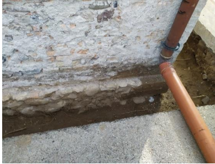
Foto 2.1.2: Fondazione tipo facciata Ovest Stato attuale
