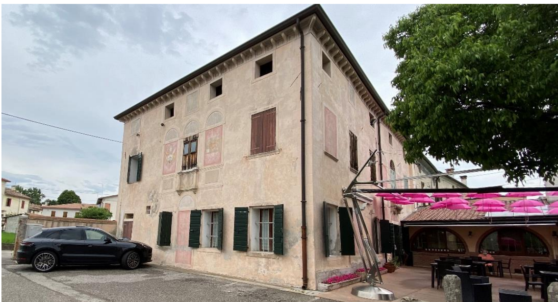
Foto 1.1.3: Prospetto sud-ovest Stato attuale
