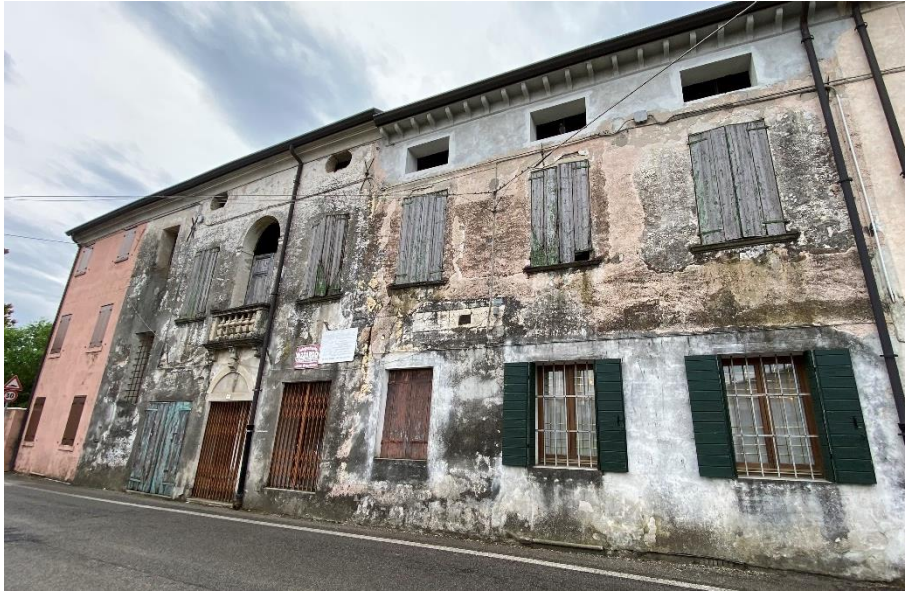
Foto 2.2.9: Facciata Sud unità Est
