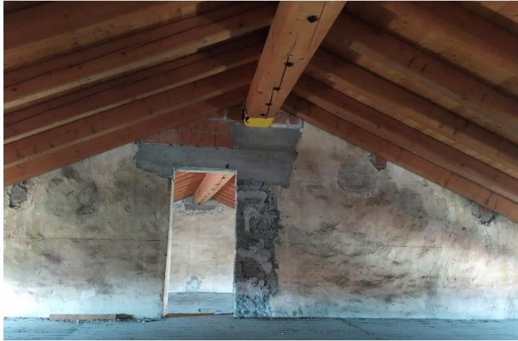
Foto 1.1.9: Copertura unità est Stato post-intervento
