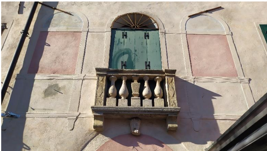
Foto 2.2.10: Balcone facciata Sud del blocco B
