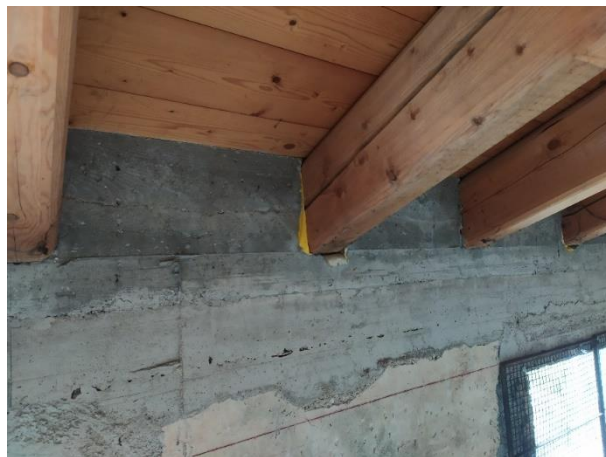
Foto 2.1.13: Esempio di incrocio travetto – cordolo di coronamento copertura Est
