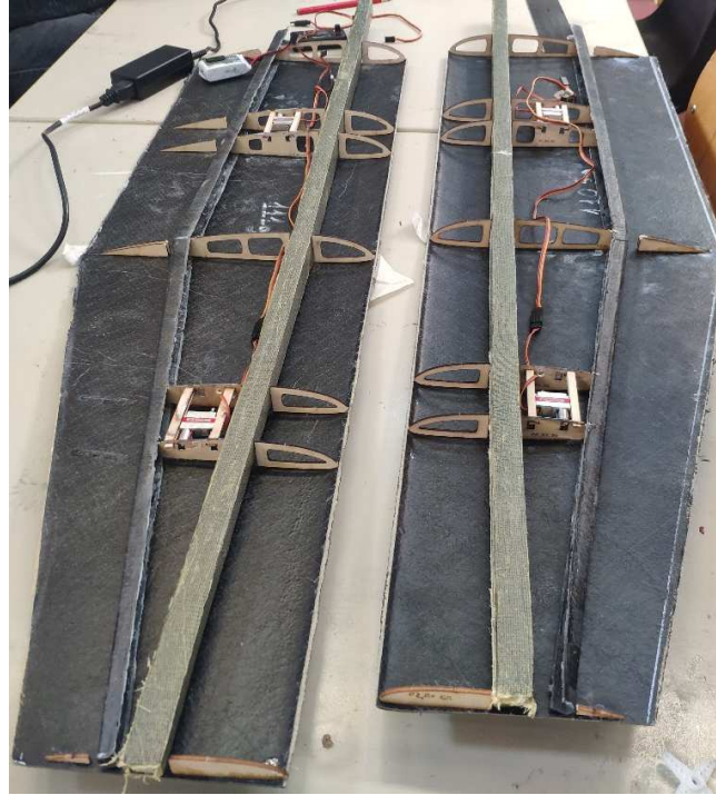
Figura 157 - Installazione della struttura interna dell'ala (centine, servocomandi e longheroni) sul mantello dell'intradosso.
