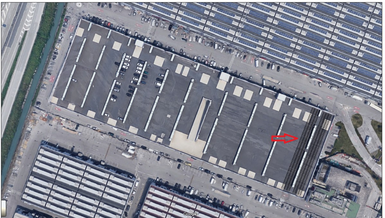
Figura 28, impianto fotovoltaico impianto 200 kWp
