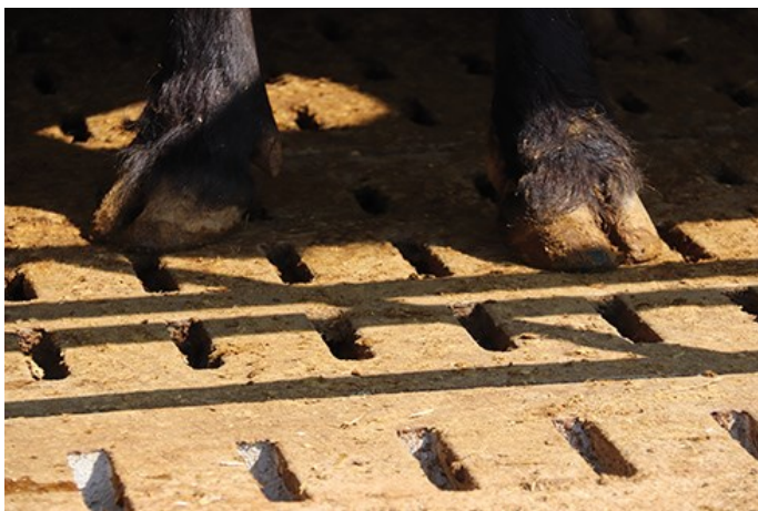
Figura 9 Pavimentazione in grigliato (Allevatori TOP Gestione Mandria)
