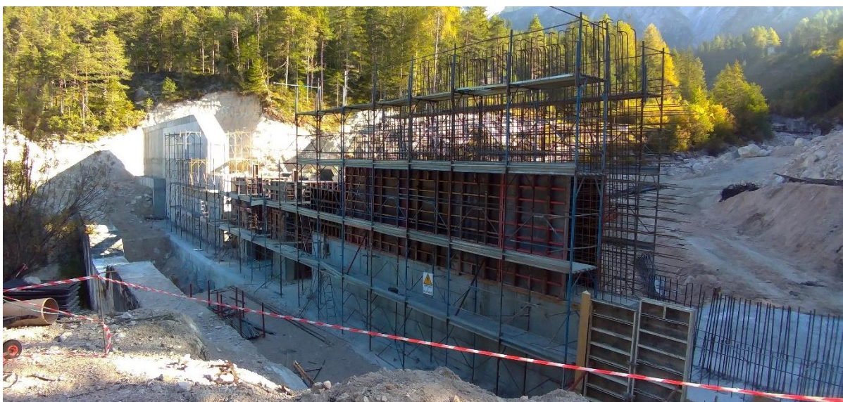
Figura 33. Briglia filtrante di valle durante la fase di realizzazione (foto scattata dall'Autore)
