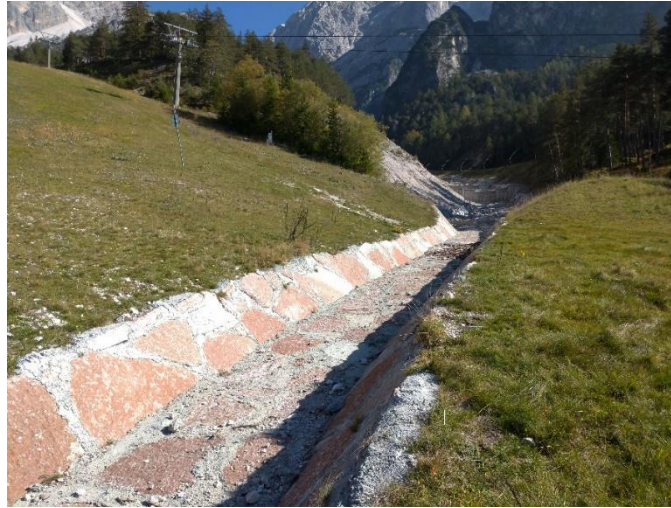
Figura 26. Canalino a sezione trapezia al di sopra del tombotto, con funzione di smaltimento dei deflussi liquidi in caso di ostruzione del tombotto (foto scattata dall'Autore)
