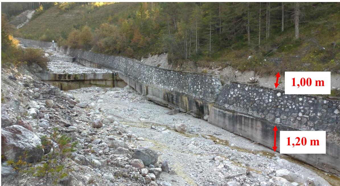
Figura 22. Muro spondale con fondazioni scoperte (1,20 m) e ad una quota di circa 1 metro inferiore rispetto alla posizione pre-colata (foto scattata dall'Autore)
