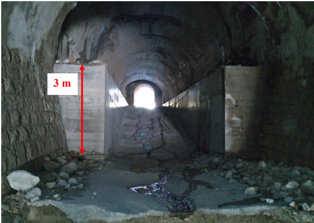
Figura 28. Ex soglia, recentemente trasformata in uno scivolo rivestito con pietrame (foto scattata dall'Autore)
