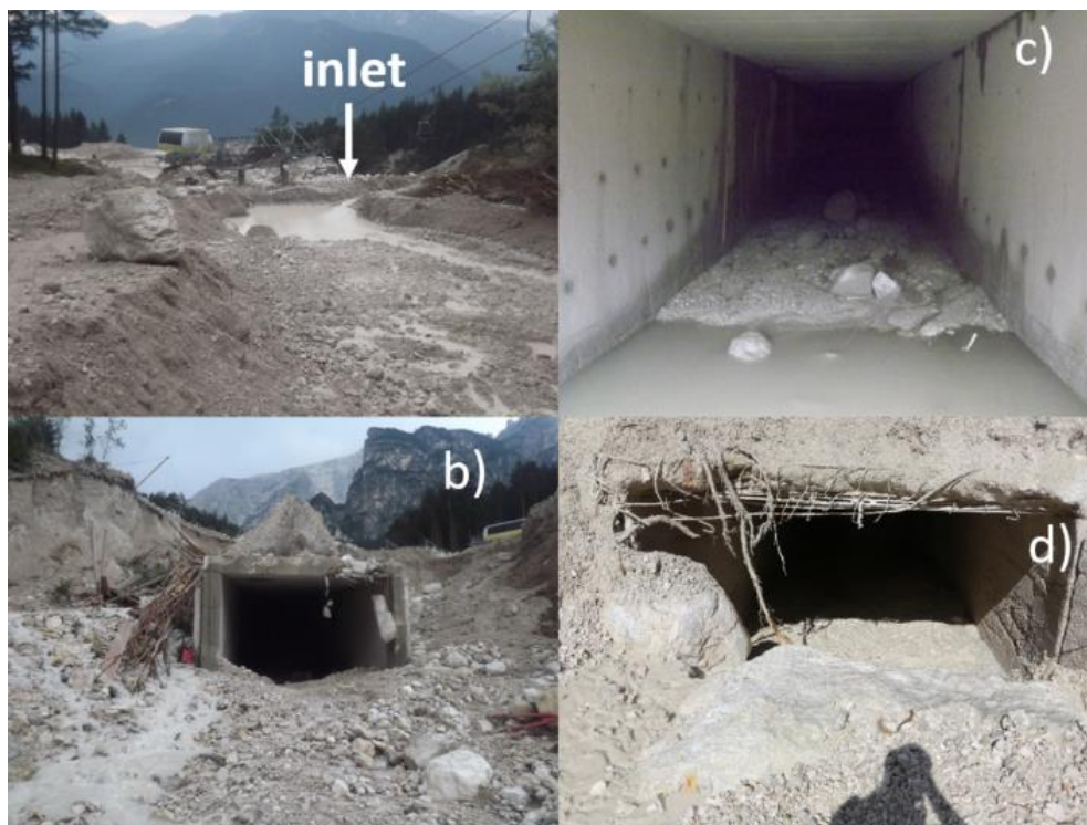
Figura 16. Stato post-evento nella zona del tombotto al di sotto della pista da sci (Gregoretti et al., 2018)
