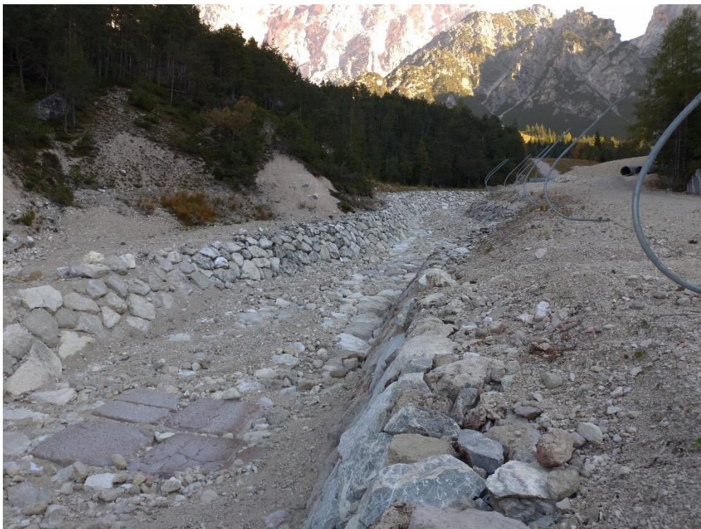
Figura 23. Massicciate aventi funzione di protezione spondale, con la presenza di blocchi incassati nel fondo aventi funzione di soglia di fondo (foto scattata dall'Autore)
