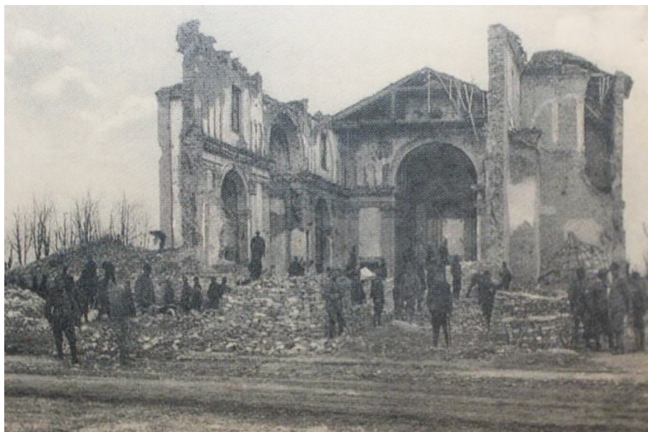
Figura 2.2.10 Cartolina della vecchia chiesa di Ponte di Piave distrutta con i prigionieri austriaci impegnati a sgomberare le macerie; BERNARDI Mario e CORAZZA Angelo, Ponte di Piave , p.72.
