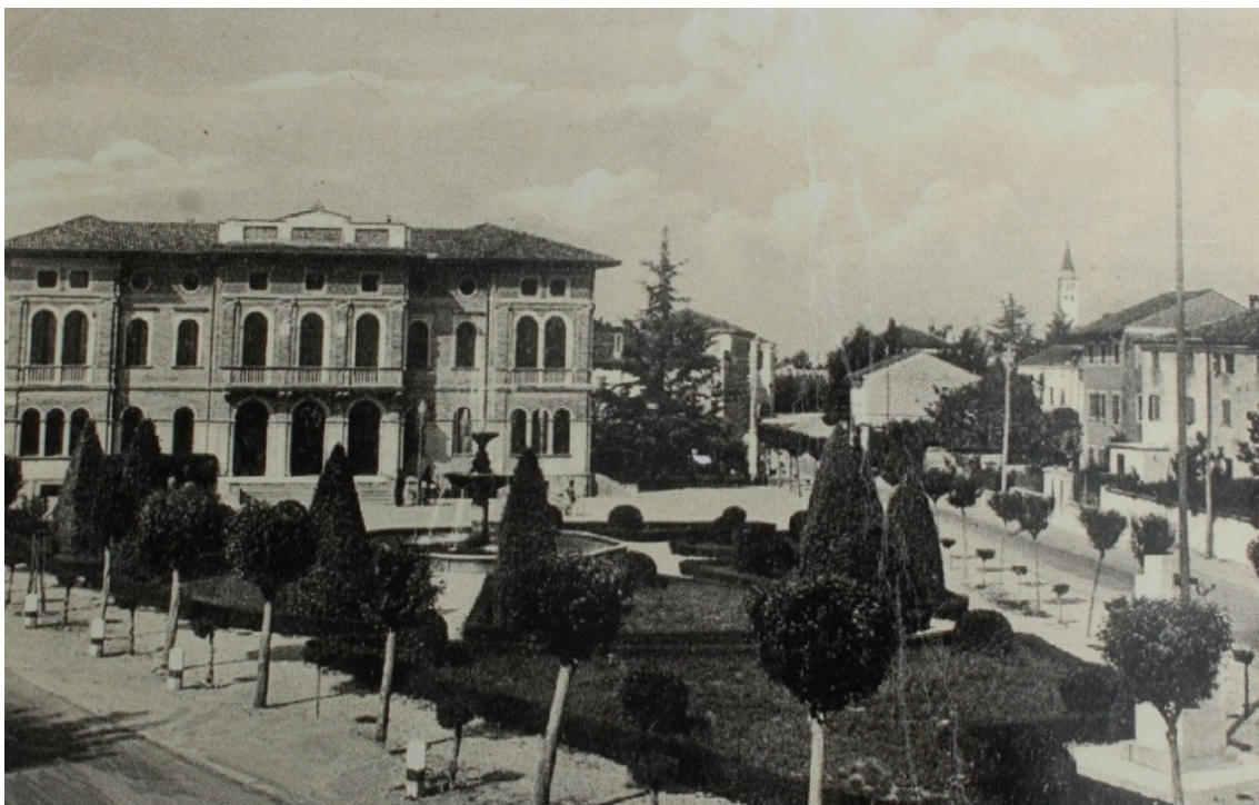
Cartolina con vista in primo piano del parco del municipio, viaggiata il 27 marzo 1959 da Ponte di Piave a Sondrio; edizione Gaion M. – Sari Cartoleria; proprietà riservata A. Cadel, Trieste; BERNARDI Mario e CORAZZA Angelo, Ponte di Piave , p.130.
