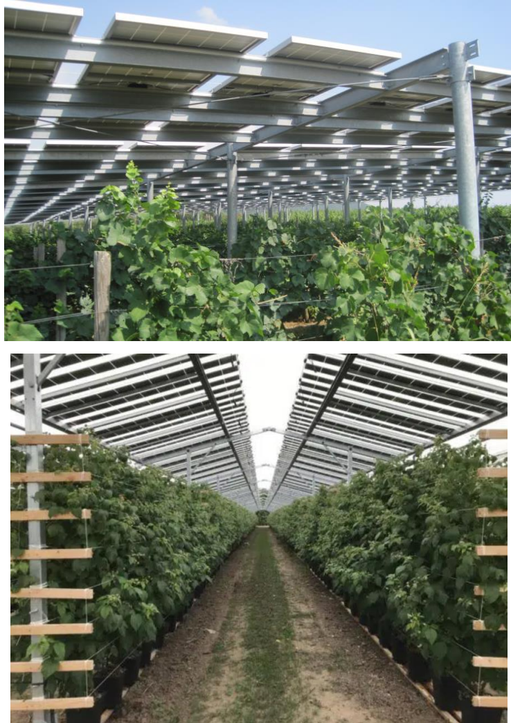
Figura 13- Sistema agrivoltaico rispettivamente su vigneto (Agrofiliera.it) e su piccoli frutti (Riccio Gianluca, 2020)
