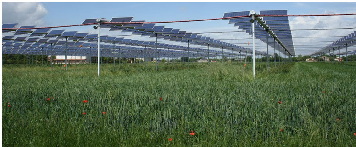
Figura 15- Impianto agrivoltaico REM Tec di Montecelli D'Ongina (REM Tec Energy)
