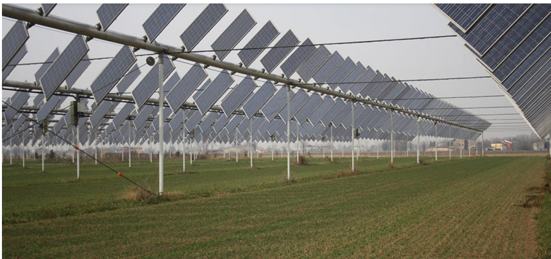
Figura 17- Impianto agrivoltaico Borgo Virgilio (Rem Tec Energy)
