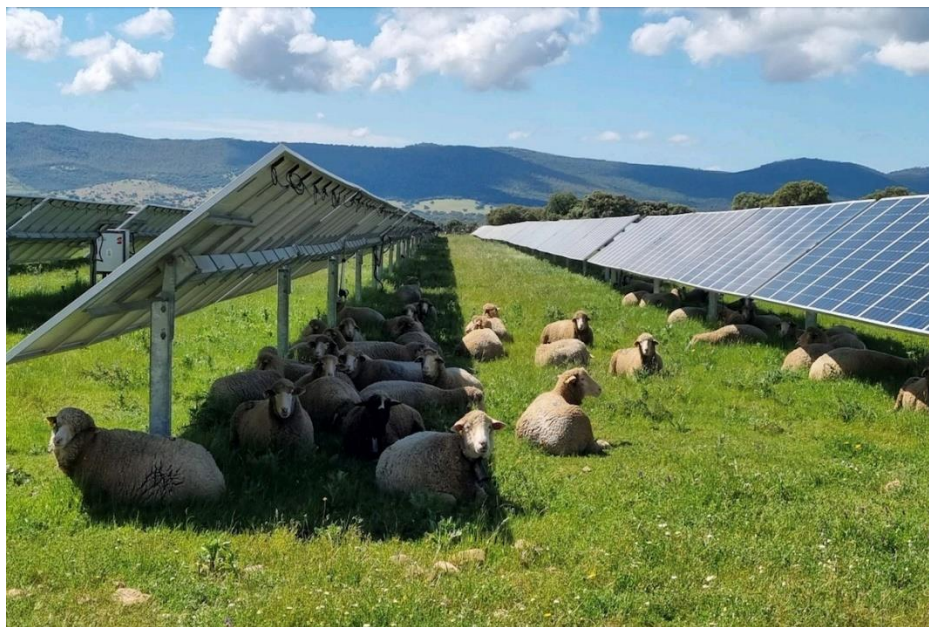
Figura 12- Sinergia tra sistema agrivoltaico con pascolo di ovini (Enel Green Power)
