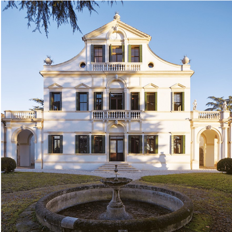
Figura 41. Prospetto sud di villa Tamagnini-Lattes, Istrana (TV)
