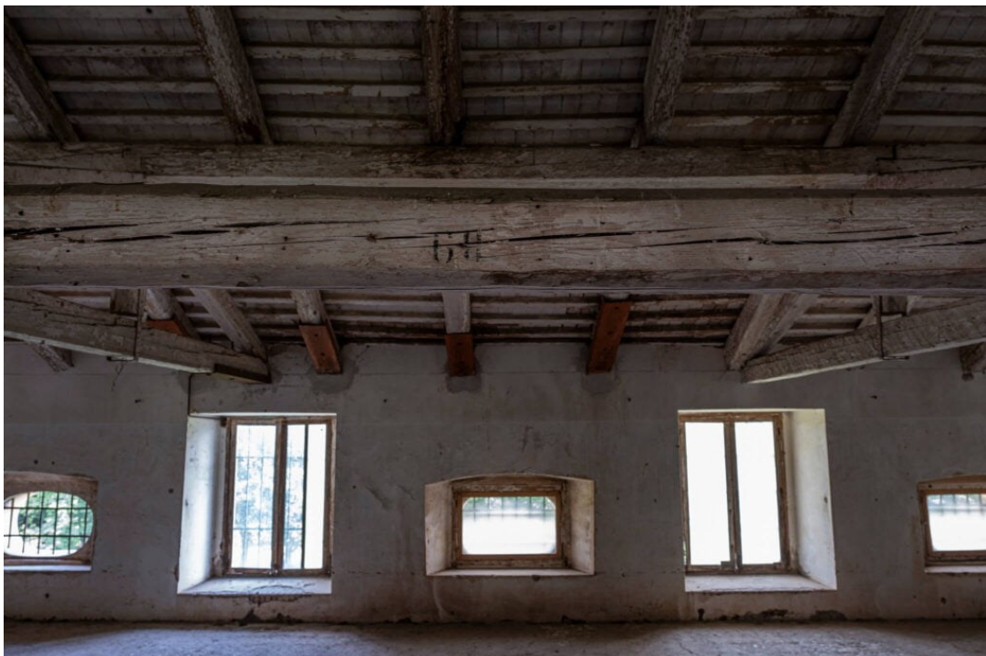
Figura 20. Sulle travi del solaio sono oggi visibili i numeri dei posti letto riservati ai feriti durante le guerre mondiali Da: Archivio Cantina Barchessa Loredan
