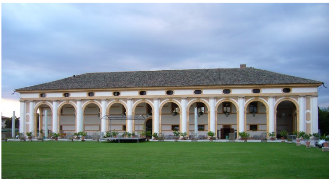
Figura 26. Prospetto Frontale della barchessa di villa Pola
