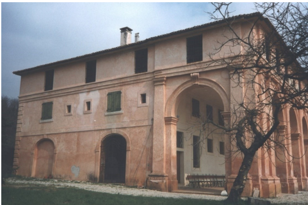
Figura 18. Vista laterale Da: Archivio IRVV
