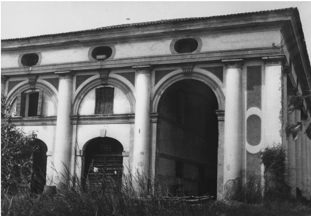
Figura 30. Fronte sud Da: Archivio IRVV
