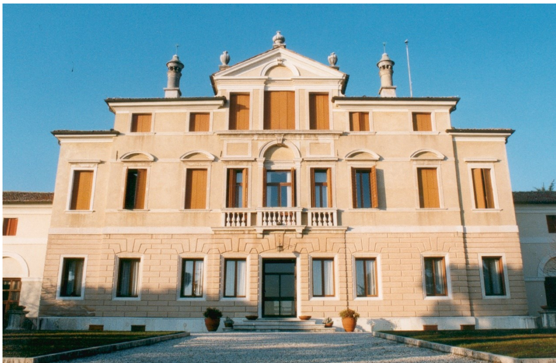
Figura 44. Prospetto sud di villa Fietta, Paderno del Grappa (TV) Da: Archivio IRVV
