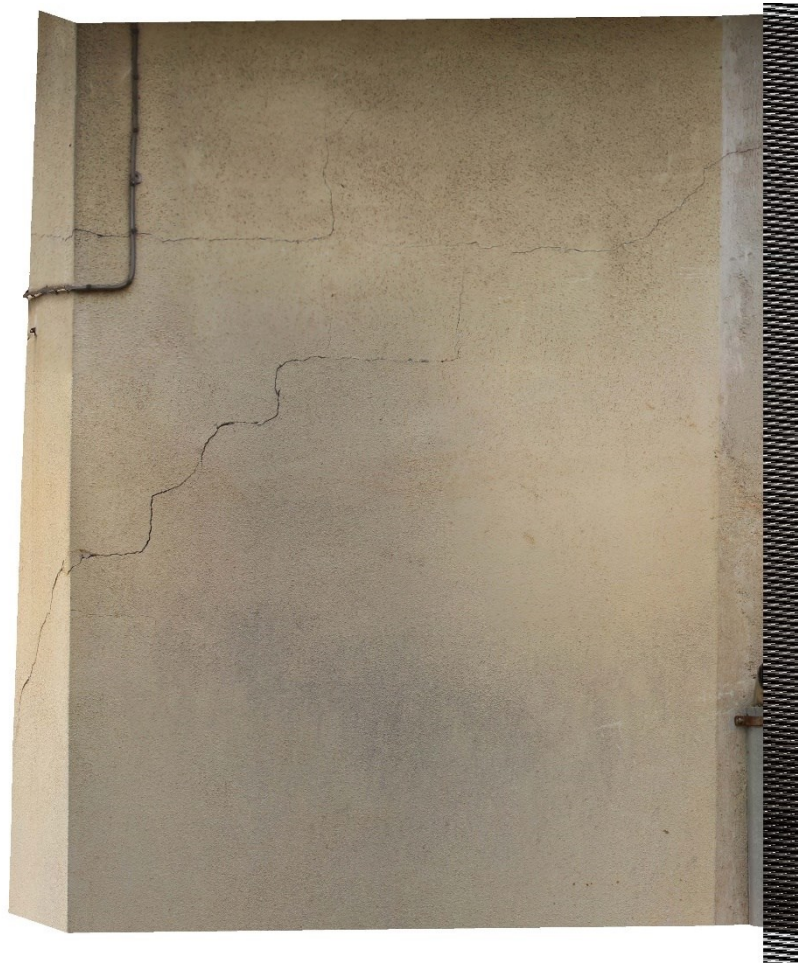
Figura 15: Ortofoto dell'edificio a Cappellazzi, anno 2019;
