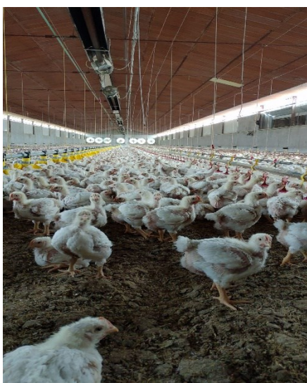
Figura 1. Capannone ad aria forzata (a) e ad aria naturale (b). Notare i ventilatori estrattori nella parete di fondo nel capannone ad aria forzata, non presenti nel capannone ad aria naturale.
