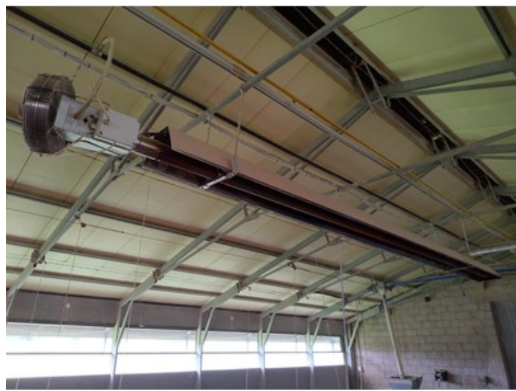
Figura 7. Cappa radiante utilizzata nei capannoni in esame (a); cappa di grandi dimensioni ad innesco e gestione della temperatura automatici (b).
