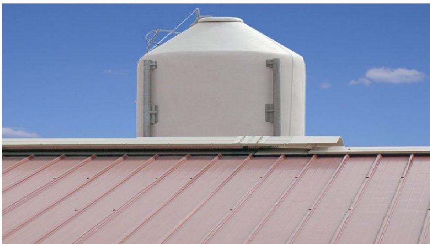
Figura 2. Particolare del cupolino sul tetto di un capannone ad aria naturale.
