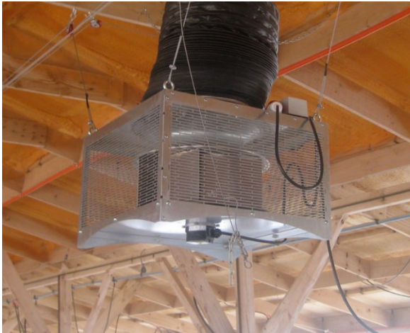
Figura 6. Riscaldamento di tipo termoconvettore con schema del funzionamento del flusso d'aria.
