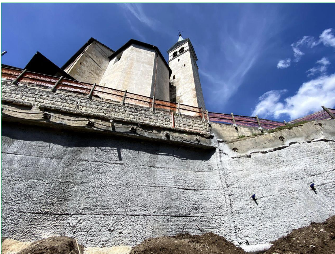
Figura 43 – Placcaggio in calcestruzzo – foto scattata in cantiere
