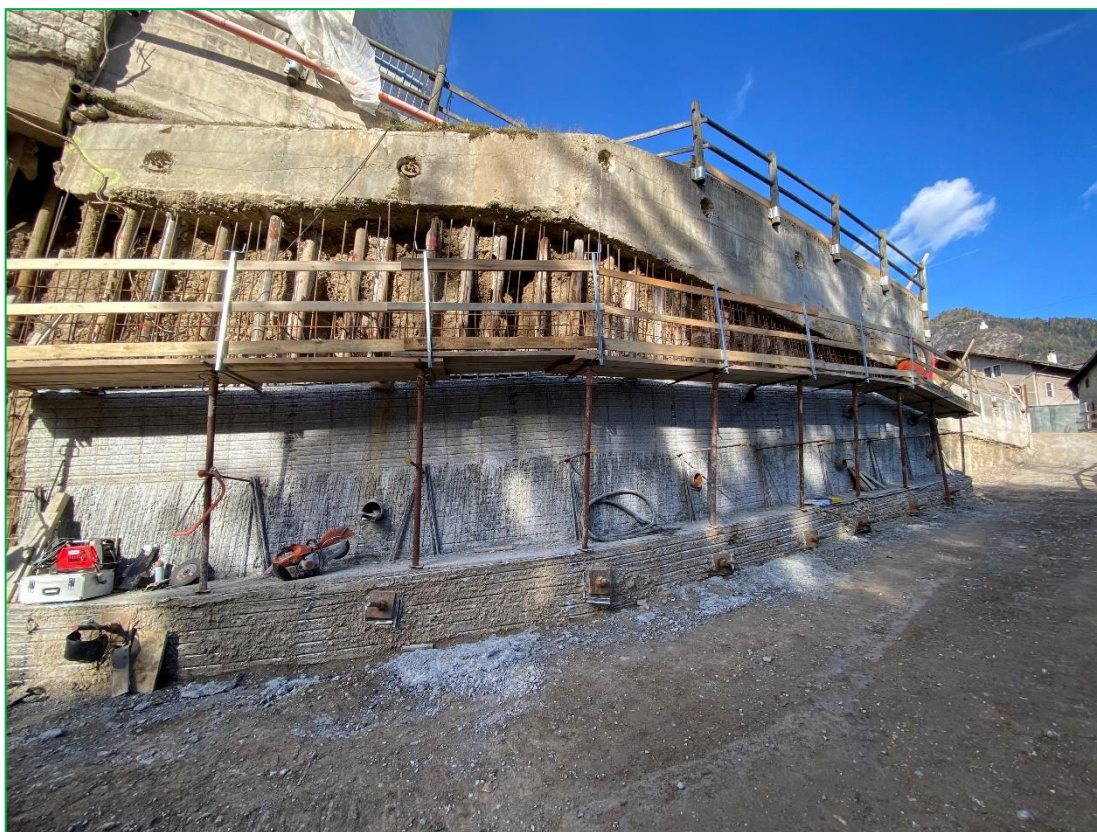
Figura 39 - Nuovo cordolo in c.a. descritto al punto a - foto scattata in cantiere in fase di esecuzione
