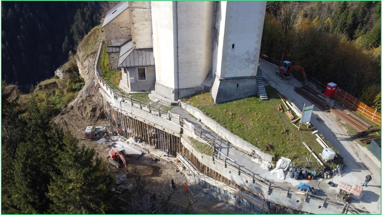
Figura 45 - foto aerea del cantiere
