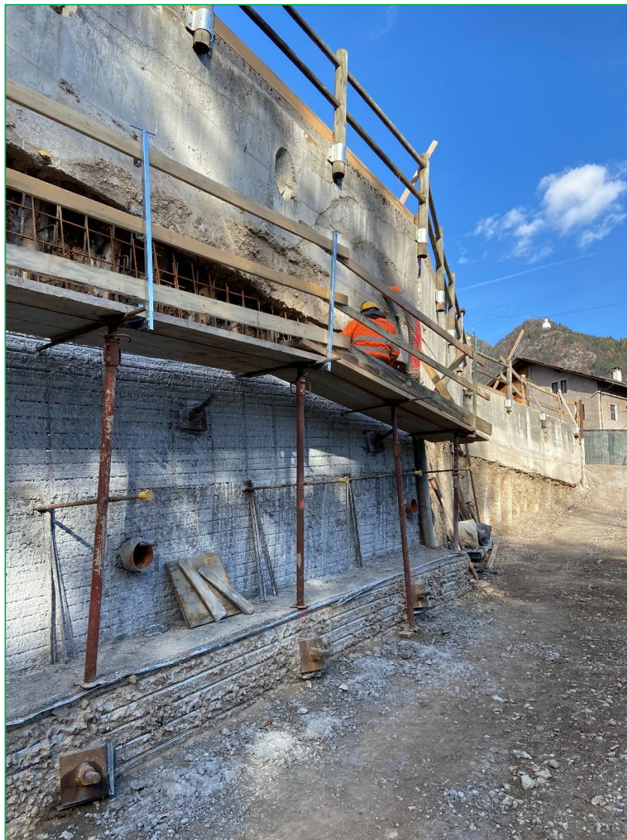
Figura 44 - Tiranti inseriti nel cordolo in c.a. - foto scattata in cantiere
