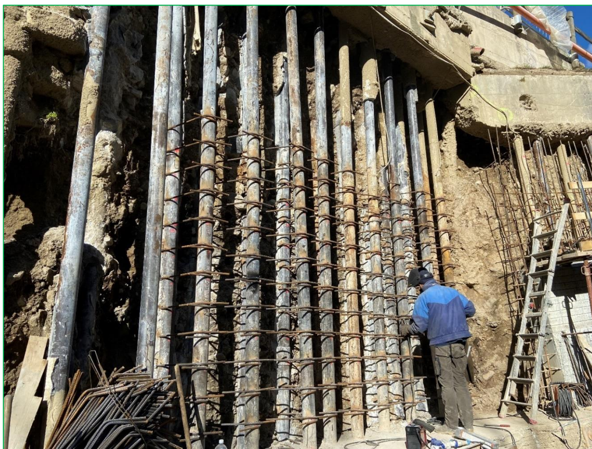
Figura 41 - Sistema di ancoraggio dei micropali tramite barre saldate - foto scattata in cantiere
