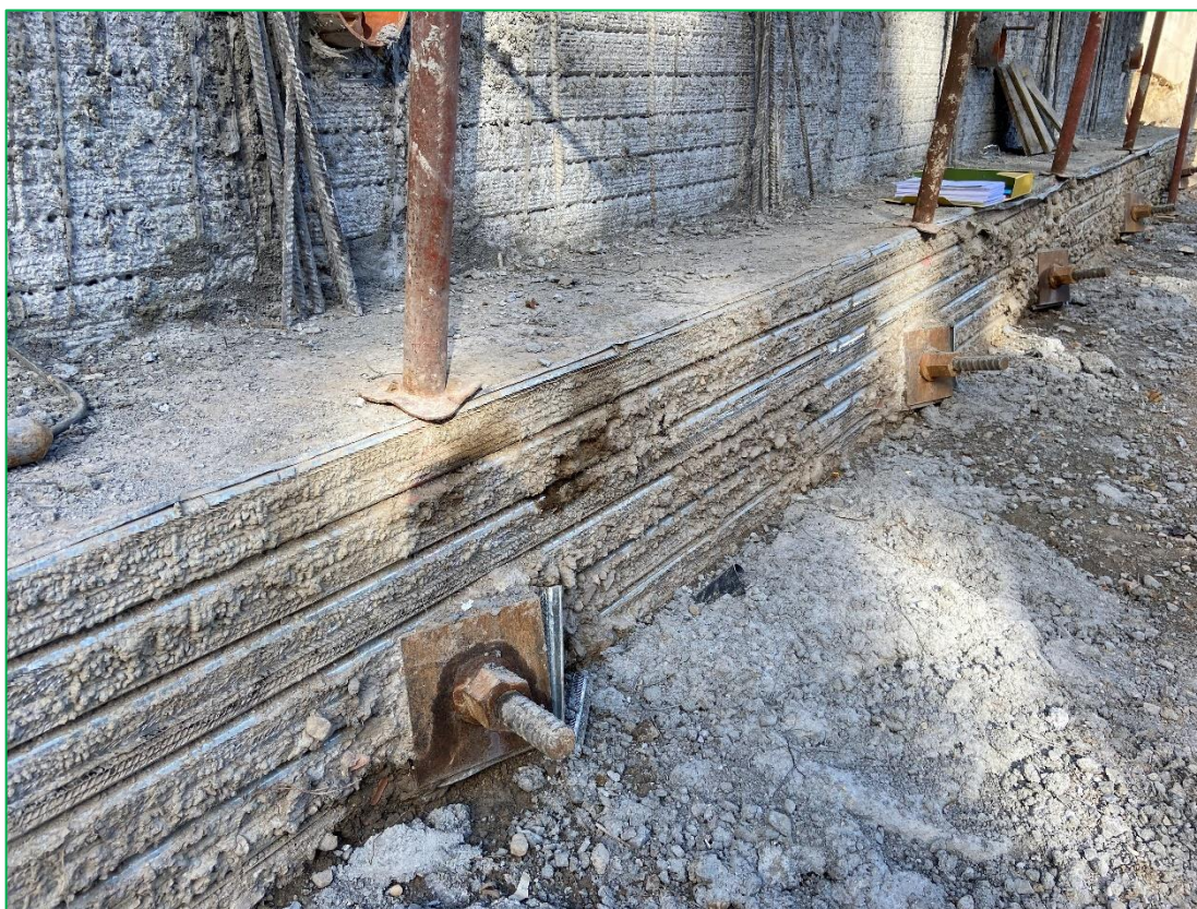
Figura 40 - Particolare dei tiranti inseriti nel cordolo in c.a. - foto scattata in cantiere in fase di esecuzione
