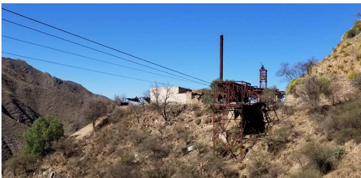
Fig. 28 : Vue de la station 3 El Parron (alt. 1.975m.), depuis le sentier d'accès. On remarque la cheminée de la chaudière, la tour contre-poids, une partie des bâtiments d'administration et d'habitation et surtout la structure de réception et d'envoi des berlines en direction de La Mejicana.
