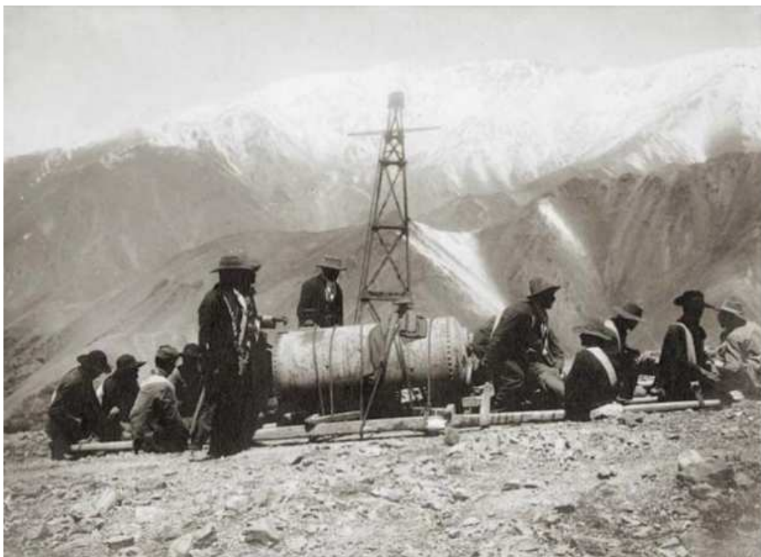
Fig. 41 : Photographie de Max Cooper vers 1904, sous-titrée « Descansando », montrant des ouvriers au repos devant une des tours du téléphérique, autour du palanquin servant à monter par le sentier la chaudière de la station 8, située à 4.370m. d'altitude. Ce transport humain mobilise douze hommes répartis en deux groupes (avant/arrière) pour porter la charge, accompagnés souvent d'un groupe supplémentaire pour assurer un roulement. Les pièces trop lourdes pour les mules comme les chaudières ou les engrenages moteurs non modulaires sont tous transportés ainsi.
