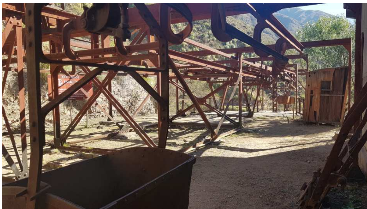
Fig. 29 : Vue de l'espace de circulation des berlines en gare de la station 3, avec ses structures métalliques pour une mobilité sur rail. On remarque à droite la guérite du receveur des berlines.
