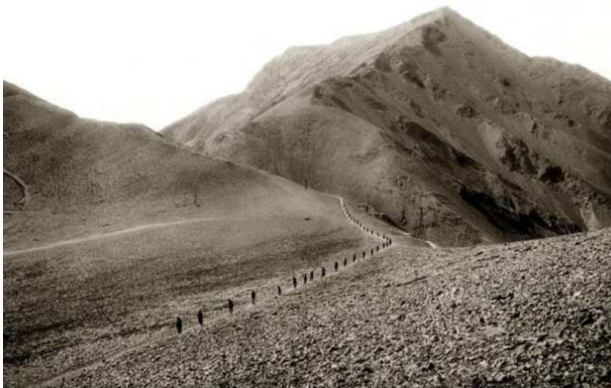
Fig. 42 : Photographie de Max Cooper vers 1914, sous-titrée « Repartiando cables en Portezuelo Ancho (seccion VII) », montrant une troupe de 33 ouvriers transportant un tronçon de câble afin de le disposer et réaliser la jonction avec le tronçon précédant. Ces liens sont réalisés par un système de pince double à vis dont le serrage assure la capture à chacune de ses extrémités les deux câbles à connecter.
