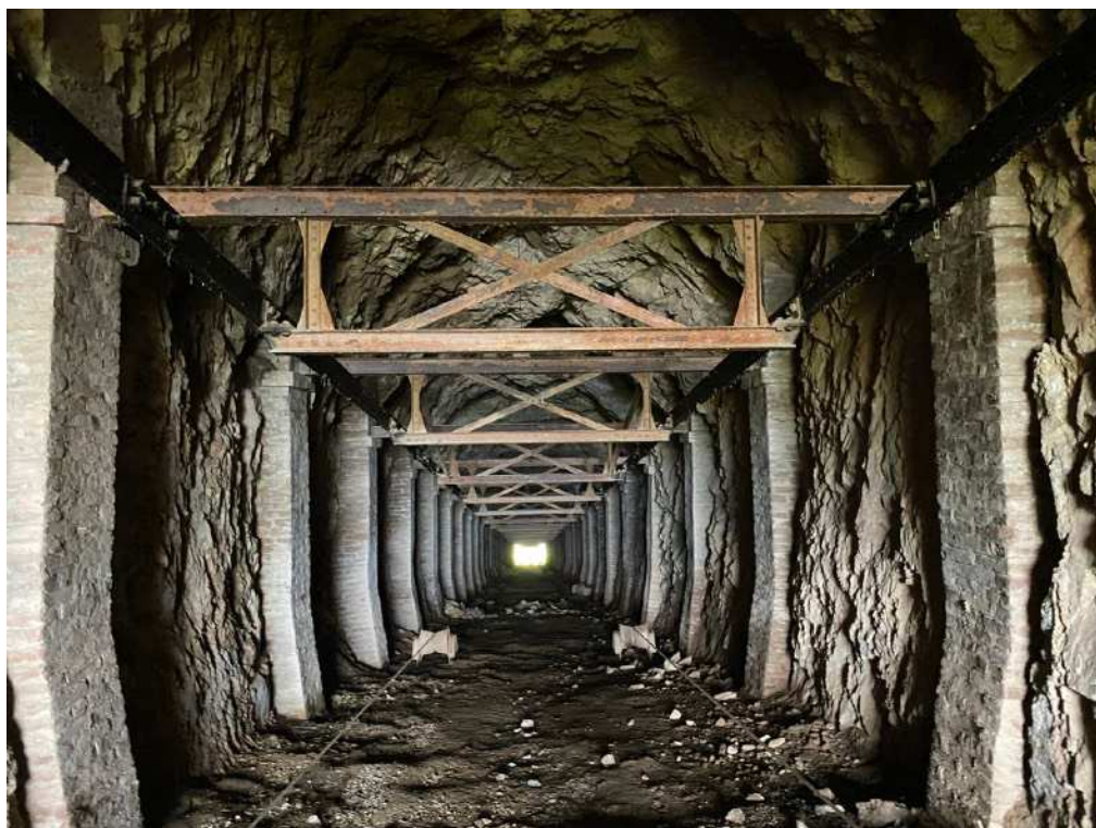
Fig. 37 : Vue de l'intérieur du tunnel, montrant les maçonneries soutenant la structure métallique formant support aux rails du téléphérique. On peut également observer au sol les roues assurant le maintien en hauteur du câble tracteur, qui redescend entre le passage de chaque berline. Sur la gauche, on peut voir les éboulis provoqués par un petit effondrement de la partie rocheuse.
