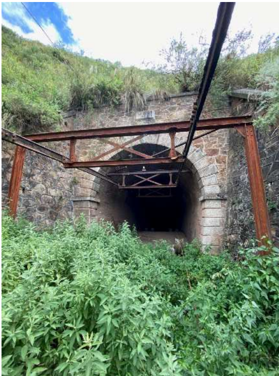
Fig. 35 et 36 : Deux vues des entrées du tunnel, à gauche l'entrée maçonnée orientée vers Chilecito est marquée par une plaque en fronton inscrite « M.O.P. 1904 » pour « Ministerio de Obras Publicas 1904 » ; à droite, l'entrée tournée vers La Mejicana montre les traces de percement. On peut également observer en sur le premier plan la fosse où pendent les contre-poids du câble, de grandes cages métalliques remplies de pierres. Une seconde est bien présente de l'autre côté également, non visible sur l'image, mais permettant le passage du tunnel sur rail.
