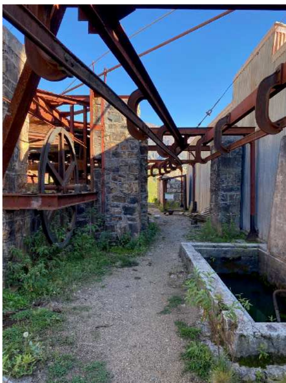
Fig. 30 et 31 : A gauche, vue de la station 4 Siete Cuestas (alt. 2.540m.), avec les rails de manutention, à gauche la roue motrice dans sa structure de pierre, mortier et métal, et à droite les constructions en tôle abritant espace de vie, salle des machines et salle de chauffe ; on distingue également la citerne d'eau assurant l'approvisionnement de la chaudière. A Droite, les sanitaires aménagés dans ce qui est sans doute un conduit de cheminée métallique.
