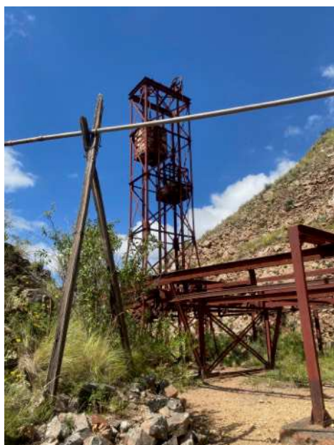
Fig. 32, 33 et 34 : En haut, vue de la station 5 Cueva de Romero (alt. 2.690m.) avec sa gare métallique marquée par la tour contre-poids et l'arrivée de la conduite d'eau captée à plusieurs centaines de mètres pour remplir le réservoir de la station. Au milieu, vue d'une partie du mobilier original conservé dans la chambre. En bas, vue de la même chambre avec son sol en damier de bois et son lit de camp métallique.
