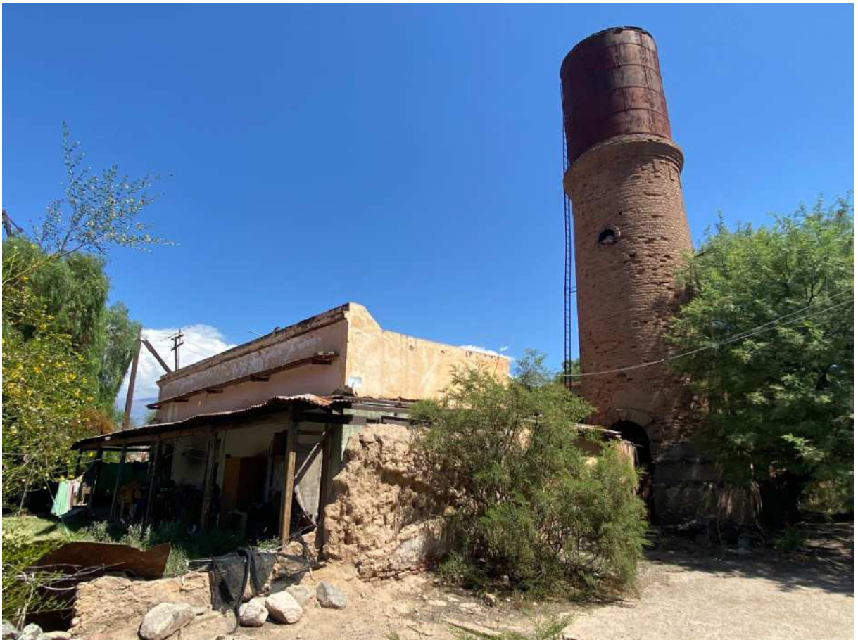
Fig. 46 : Vue du bâtiment de magasins et d'administration du chemin de fer. On note la présence imposante de la citerne métallique montée sur une tour en briques, et à l'arrière plan celle de la grue en bois de la station 1 du téléphérique minier. Les auvents de l'autre côté du bâtiment abritent les berlines et leurs mécanismes de suspension déposés.
