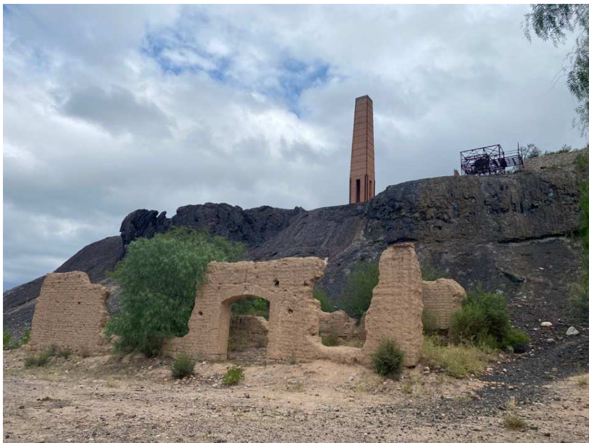
Fig. 49 : Vue des anciens magasins et bâtiments d'administration, dont la terre crue se détache sur le fond du monticule de scories, dominé par la cheminée du four et le terminal du téléphérique.
