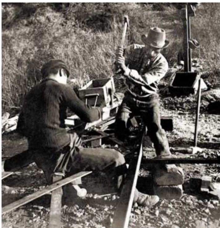
Fig. 43 : Photographie de Max Cooper, vers 1904, sous-titrée « Remachadores, Torre 135 », montrant une équipe de deux riveteurs martelants des rivets pour joindre deux éléments métalliques de la tour 135 du téléphérique
