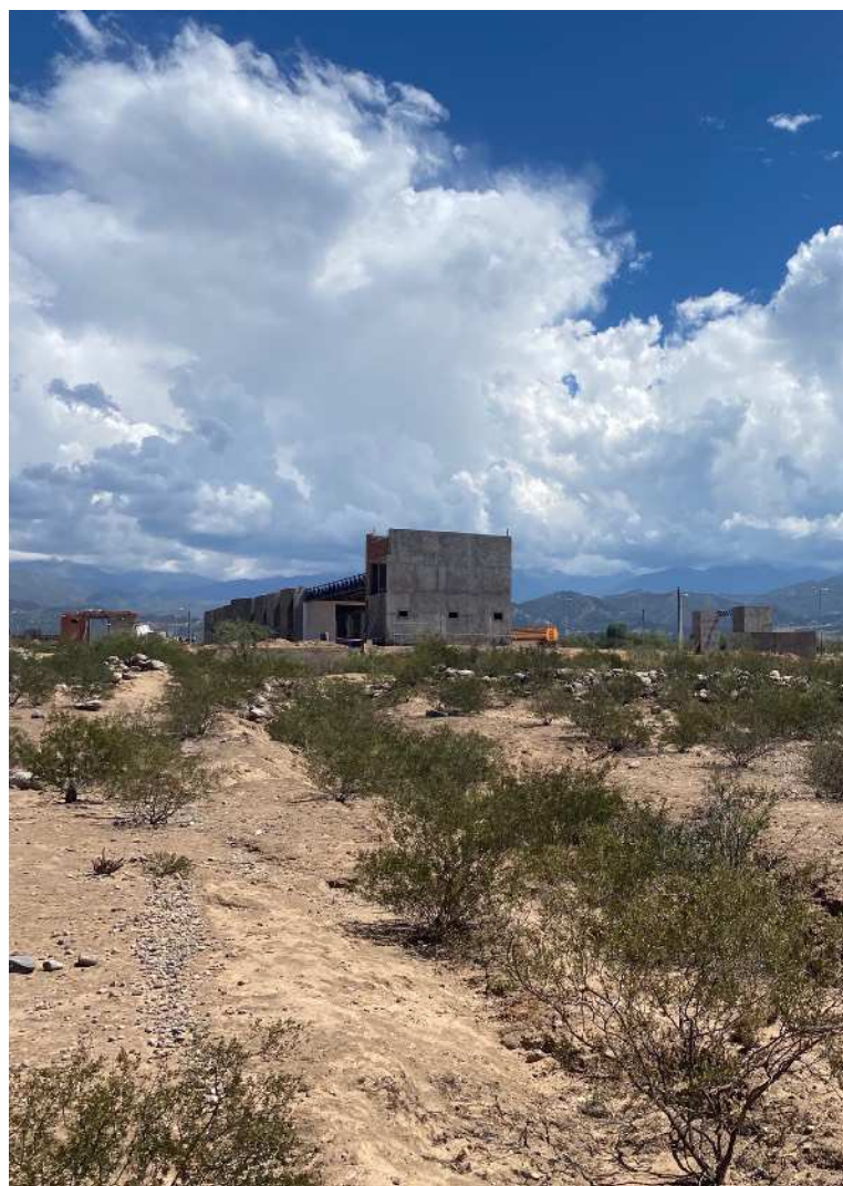
Fig. 57 : Vue de l'état du chantier du musée de la Tamberia del Inca dans son état de mars 2023, vu depuis le site archéologique.
