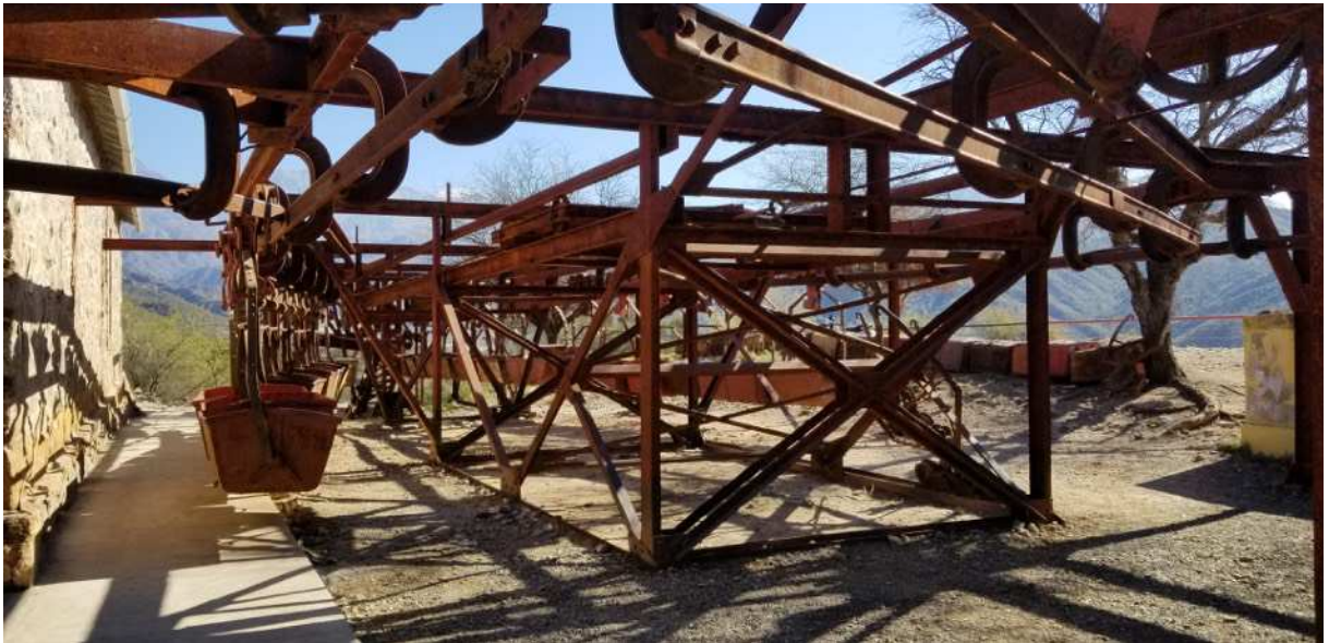
Fig. 25, 26 et 27 : En haut à gauche : vue de la chaudière de la station 2 El Durazno (alt. 1.540m.), la plus récente dans sa production mais la première à avoir été installée sur le réseau ; la puissance plus importante de cette station lui permet de mettre en fonctionnement le tronçon le plus important (8.960 mètre) et profitant le moins du jeu de contre-poids qu'exercent les berlines remplies dans les zones de dénivelé important. En haut à droite : vue de briques Cartcraig de facture écossaise. En bas : vue d'un espace d'entreposage des berlines ; la station 2 possède après la station terminale de Chilecito la plus importante zone de dépôt.
