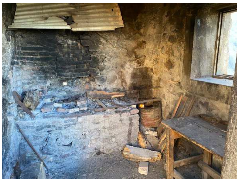
Fig. 53 et 54 : Deux exemples d'aménagements réalisés par les usagers randonneurs des stations du téléphérique : en haut, l'abri aménagé en station 5 avec les tôles d'une construction effondrée, afin d'offrir un espace où pouvoir faire du feu en sécurité ; en bas, la cuisine de la station 6 avec son auvent pour l'évacuation des fumées improvisé d'une autre tôle suspendue avec des fils de fer.
