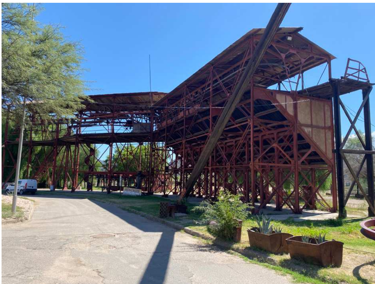
Fig. 22 : Vue de la Station 1 Chilecito (alt. : 1.075m.). On observe en premier plan le pied arrière de la grue en bois et quelques berlines transformées en jardinières lors du dernier plan d'aménagement. La station elle-même se compose en deux ailes coudées, celle de gauche assurant l'arrivée et le départ des berlines à l'étage et l'entreposage au niveau de la rue, celle de droite assure le déversement des minéraux transportés le long de rampes, qui peuvent remplir directement les wagons de train dont les voies passent en-dessous.
