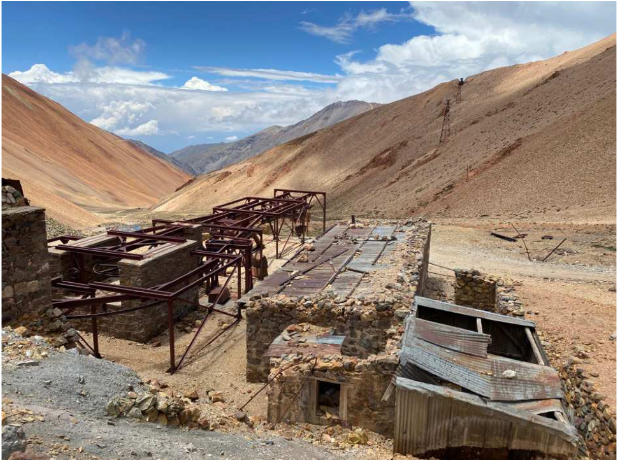
Fig. 40 : vue de la station 9 La Mejicana (alt. 4.600m.) avec ses principaux bâtiments. Le mur de gauche correspond aux rampes de chargement des berlines.
