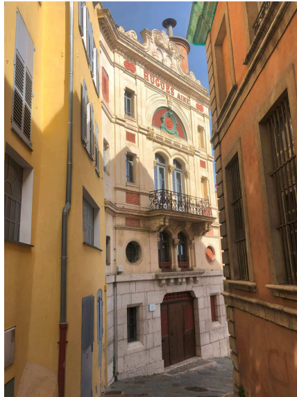
Ancienne bâtisse de l'usine Hugues Ainé, vieux Grasse.
