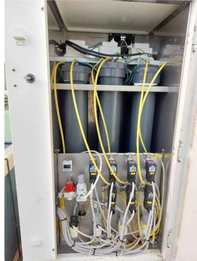
Figura 11 A sx) Tubi ionizzanti Jonix water dalla portata di 5 L/min;
