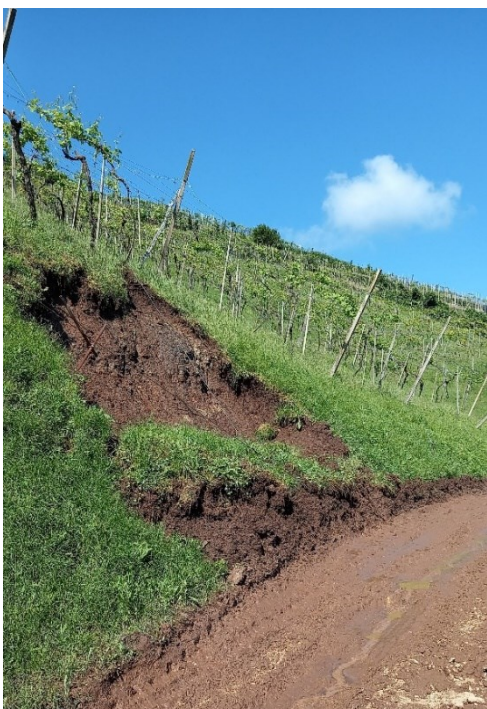
Fig.3.2.23: scivolamento rotazionale sul sentiero tra la zona A e la zona B.
