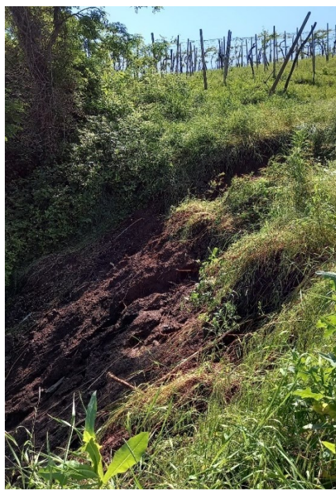
Fig.3.2.24: scivolamento traslazionale sul sentiero tra la zona A e la zona B.
