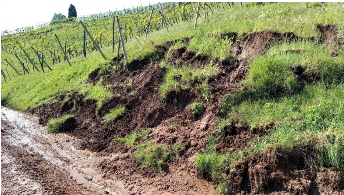
Fig.3.2.22: scivolamento rotazionale sul sentiero tra la zona A e la zona B.
