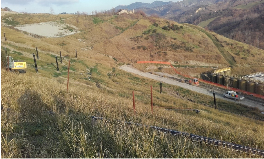
Figura 16 – porzione di terreno interessata alla realizzazione del capping (Ecomondo 2019)
