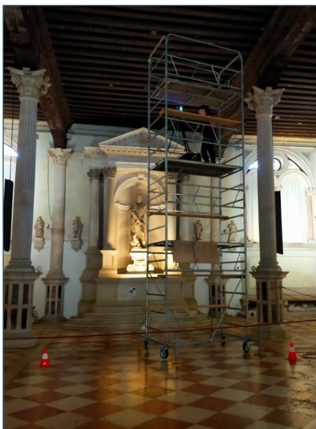
Figura 20 – Acquisizione del Faro Focus Premium posto sul trabattello
