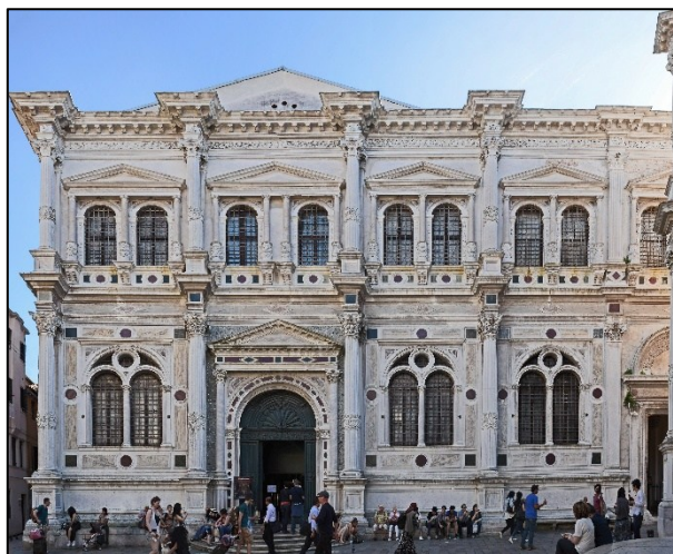
Figura 2 – Veduta frontale Scuola Grande di San Rocco
