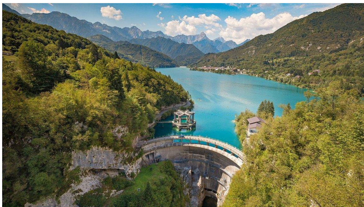
Figura 2 -Diga di Barcis (fonte: dolomiti.it)
