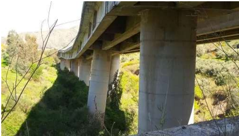
Figura 3.2 Rotazione verticale delle pile del Viadotto Himeria (www.meteoweb.eu)
