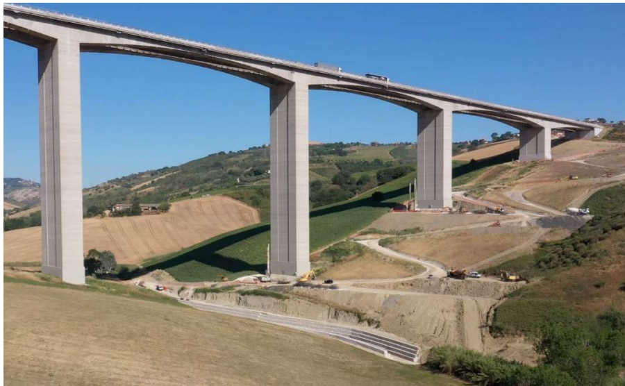
Figura 3.9 Viadotto Cerrano A14 (zappabenedettosrl.it)
