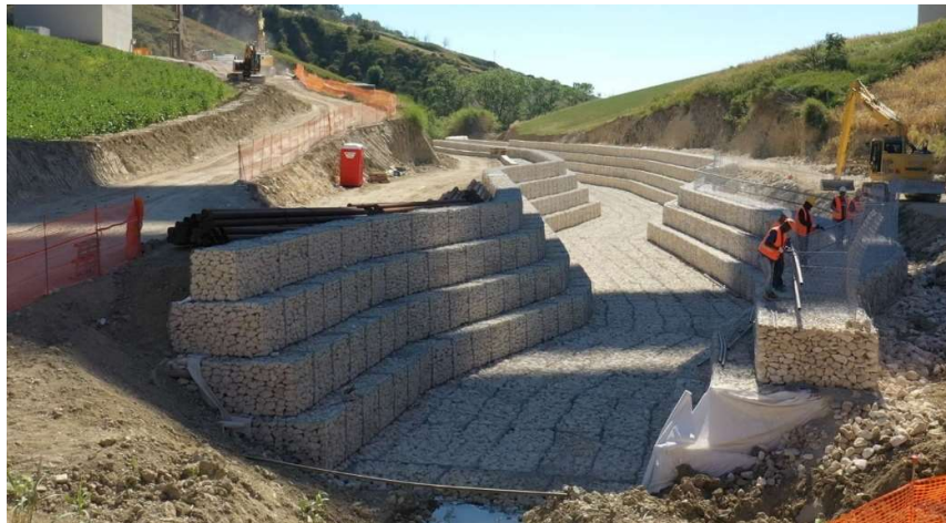
Figura 3.11 Intervento di riprofilatura dell'alveo sotto il viadotto Cerrano (zappabenedettosrl.it)
