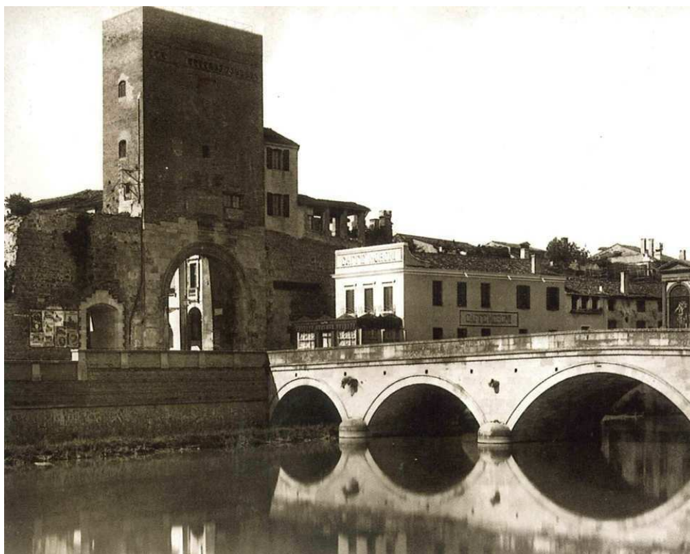
Figura 1.7 - La torre di ponte Molino, sopraelevata per inserire le vasche di pressione.
