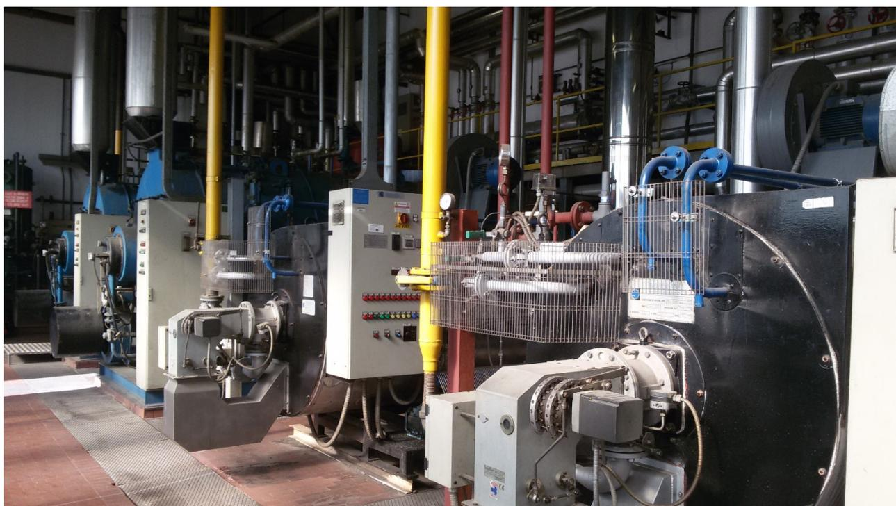
FIGURA 8 – I QUATTRO GENERATORI DI VAPORE POSIZIONATI ALL'INTERNO DELLA CENTRALE TERMICA
