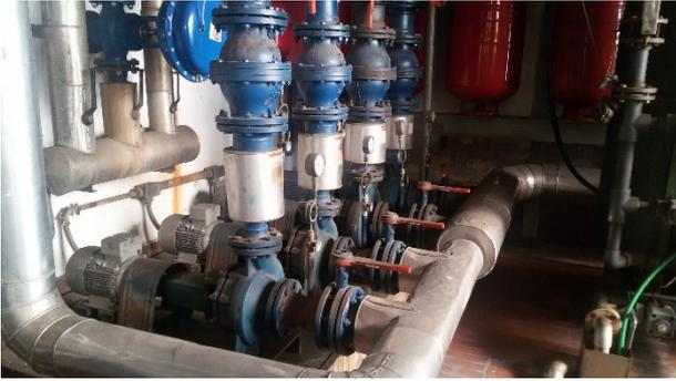
**FIGURA 11 – GRUPPI DI POMPAGGIO PER L'ACQUA DEL CIRCUITO DI RISCALDAMENTO**
