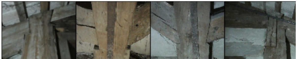
Fig. A.13: Capriata "Tipo A-C" - Rilievo fotografico dei principali nodi di carpenteria.
