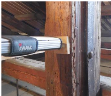
Fig. 4.41: Esecuzione di una prova resistografica con tester.
