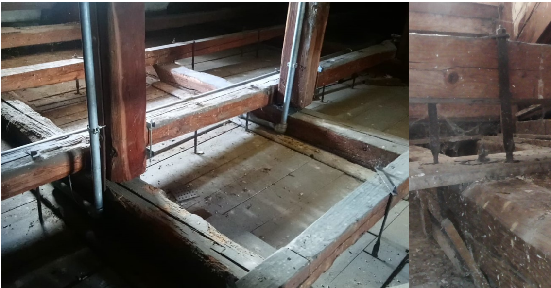
Fig. 6.4: Sistema di sospensione della 'Zona B' (sx) e particolare della staffa ritorta (dx).
