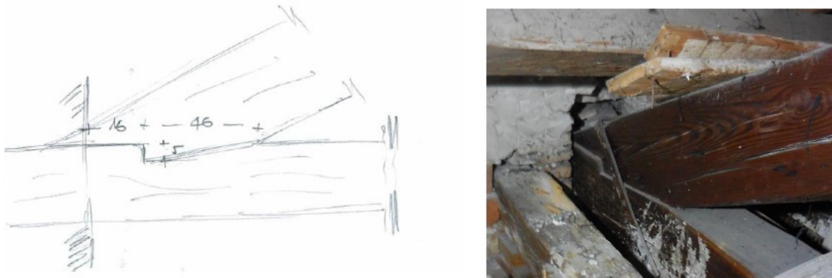
Fig. 4.25: Rilievo geometrico e fotografico del nodo puntone-catena della 'Capriata Tipo B'.
