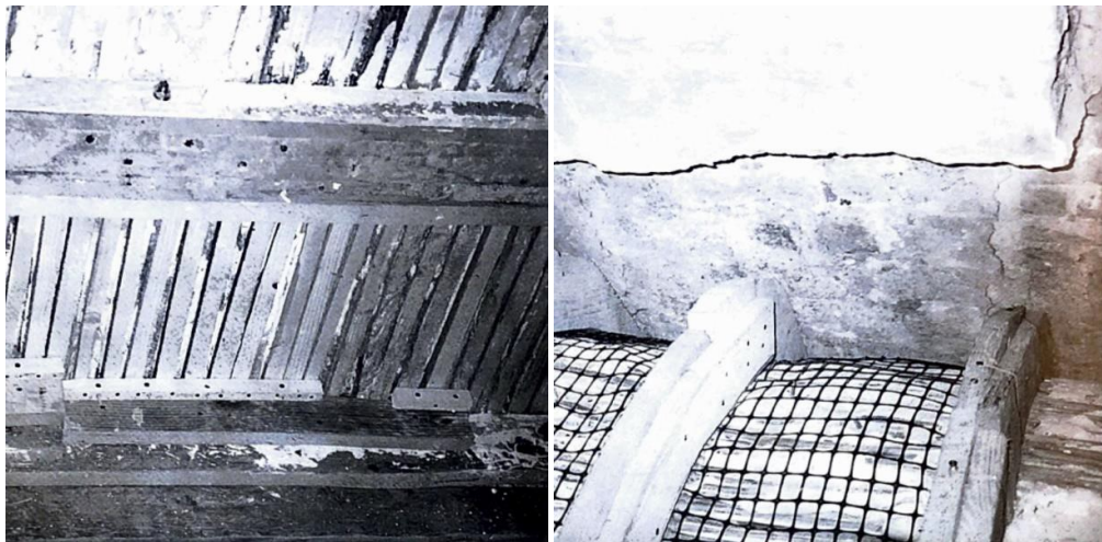
Figg. 4.18 a-b: Interventi di restauro sulle strutture lignee dei soffitti del piano nobile (Rallo, 2000).
