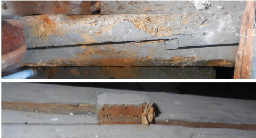
Fig. 4.31: Rilievo fotografico del giunto a 'dardo di Giove'.
