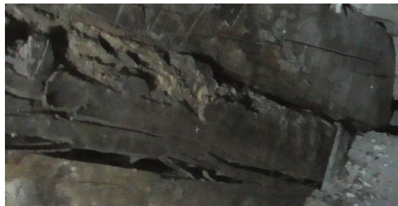
Fig. 6.6: Rilievo fotografico della testa del puntone della Capriata C10.
