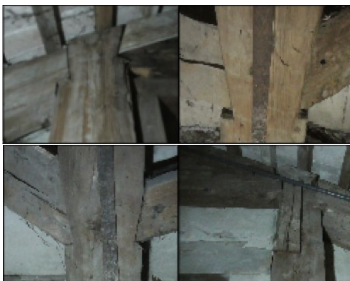
Fig. 4.35: Rilievo fotografico delle connessioni di carpenteria della Capriata A1.
