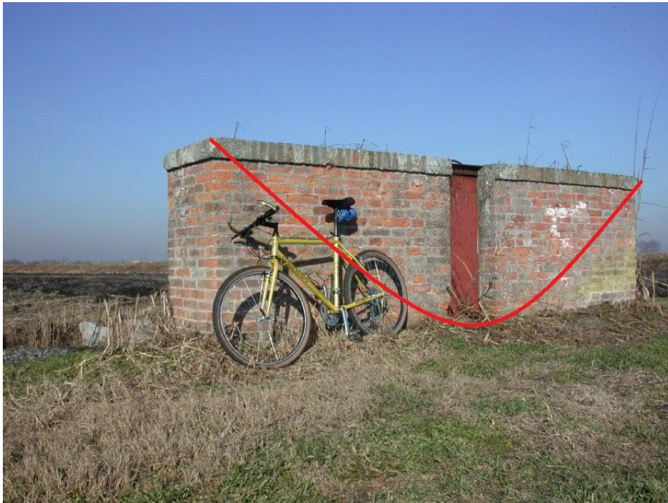
Foto 20: L'effetto della subsidenza: una vecchia chiusa abbandonata perché più alta rispetto al piano campagna. La linea tracciata in rosso indica il livello originale del corso d'acqua. Fonte: Camporese et al. , (2005)
