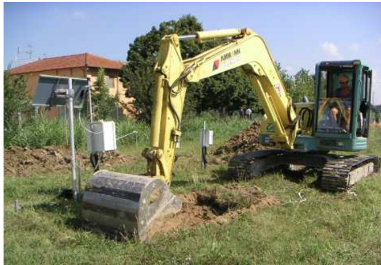
Figura 2.5: Scavo per il posizionamento delle sonde TDR.
