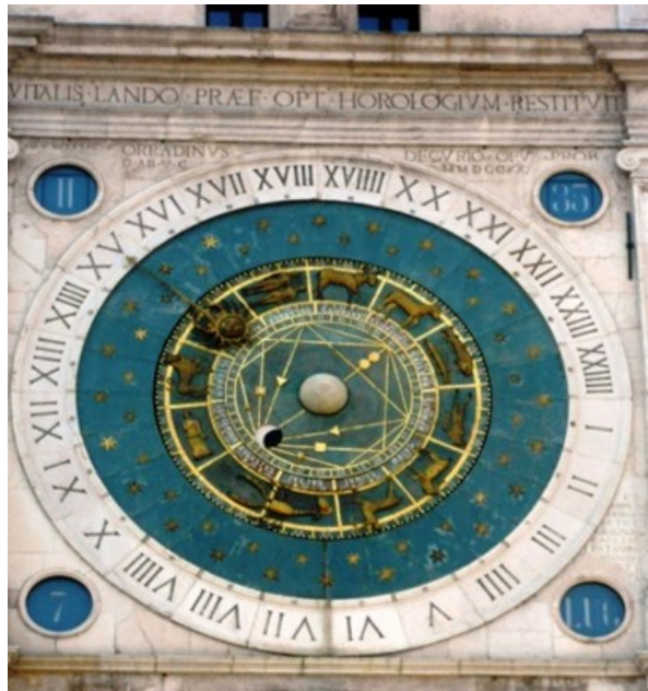
Veduta dell'orologio sulla torre carrarese, 1344, Piazza dei Signori, Padova, h 30m
