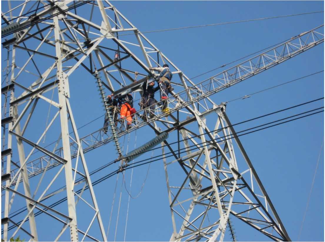
Ponte di lavoro per la modifica della testa del sostegno 115
