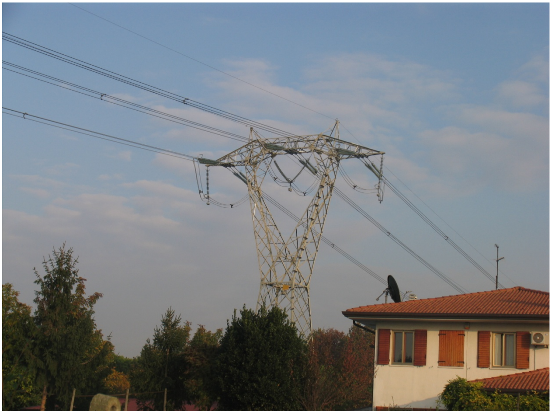
Sostegno in amarro con richiamo collo morto
