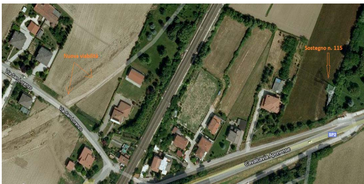
Vista aerea dell'intervento
