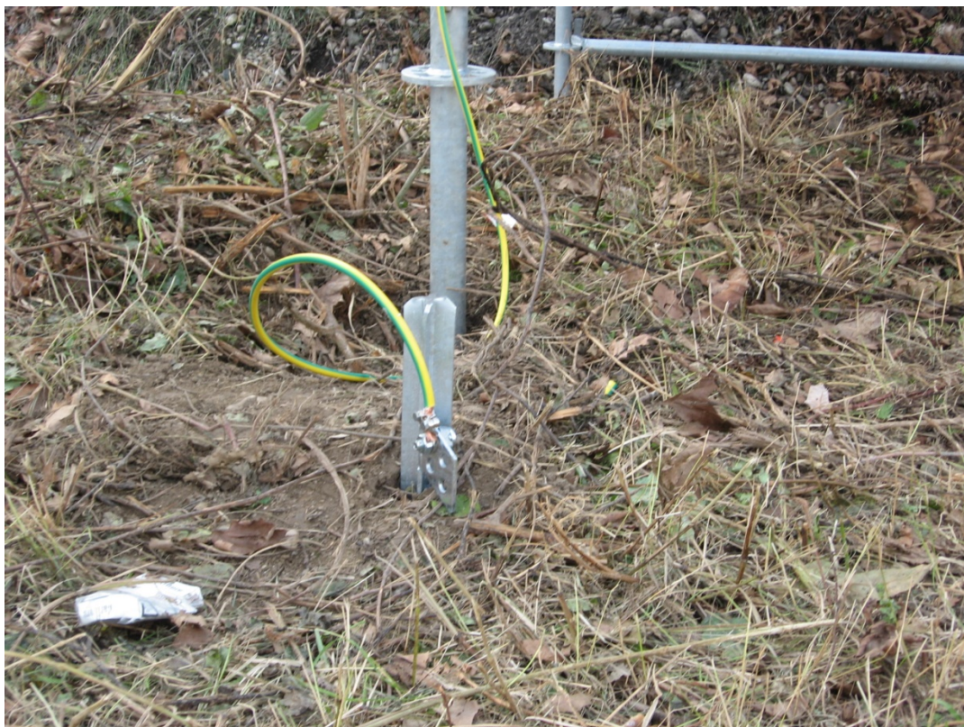
Costruzione ponteggio e relativa messa a terra con linea FS e 380 kV in servizio
