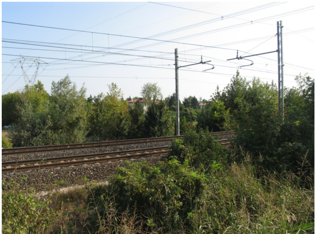
Interferenza campata 114 – 115 linea ferroviaria PD- BO al km 114 +709
