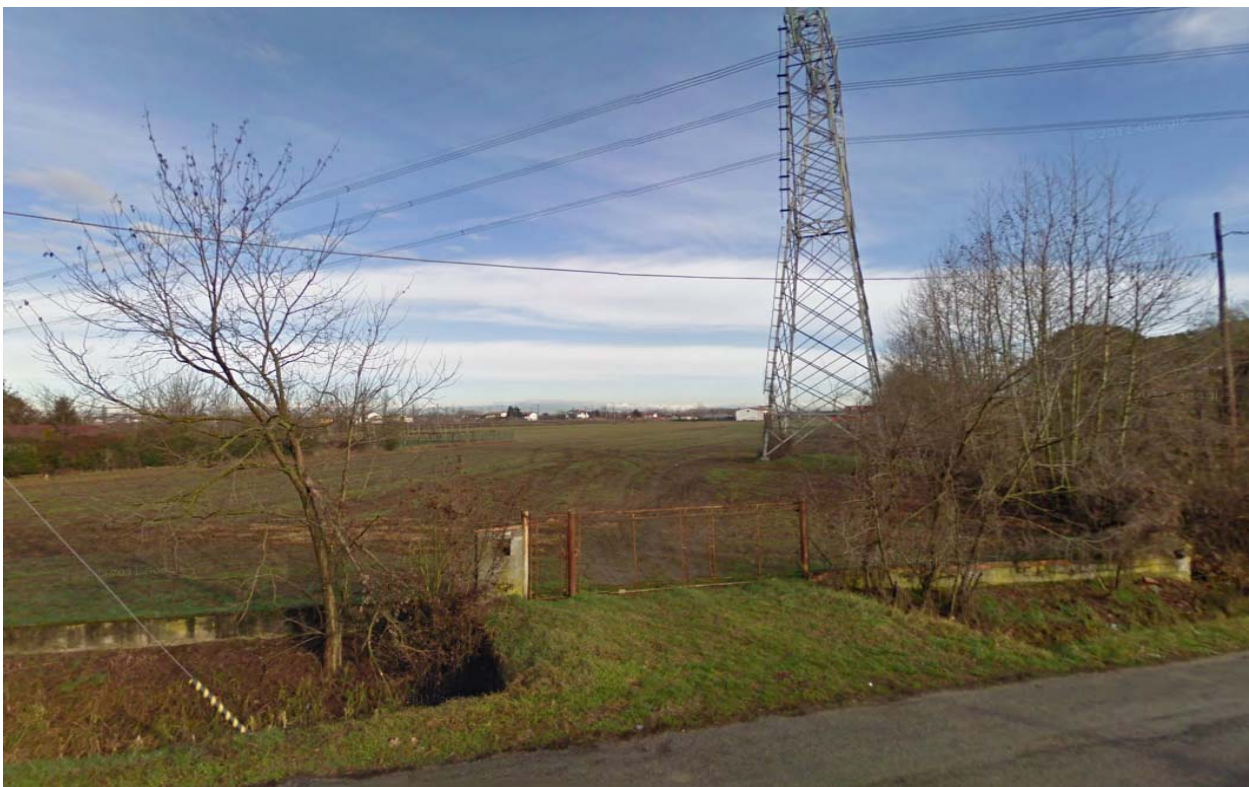
Accesso all'area di cantiere dalla viabilità ordinaria
