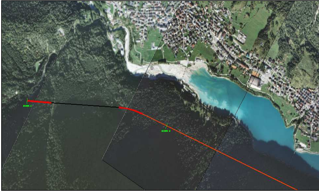
Fig. 46 - Spezzone della linea ferroviaria in esame
