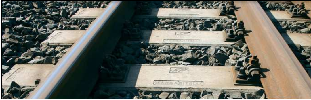
Fig. 6 – Esempio di traverse in calcestruzzo armato precompresso
