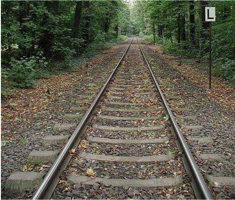
Fig. 4 – Esempio di allocazione delle traverse ferroviarie
