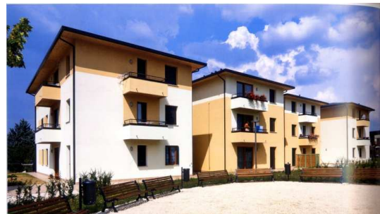
Fig. 6.3 Foto della realizzazione [4]
