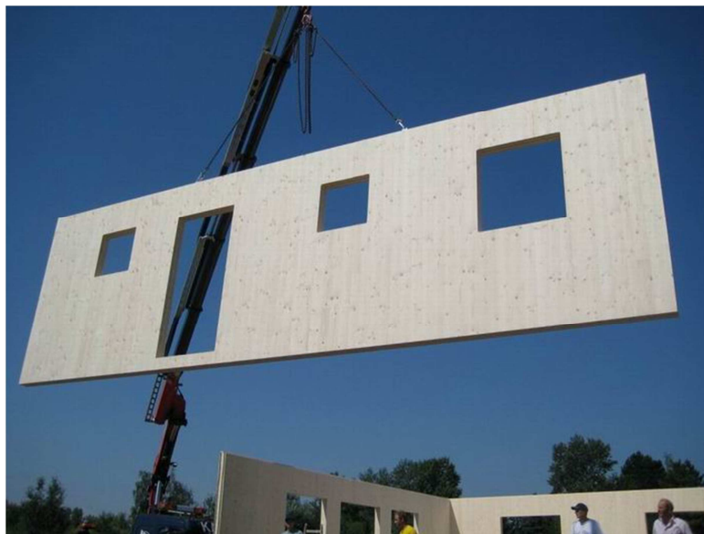
Fig 1.2 Montaggio di una parete XLam
