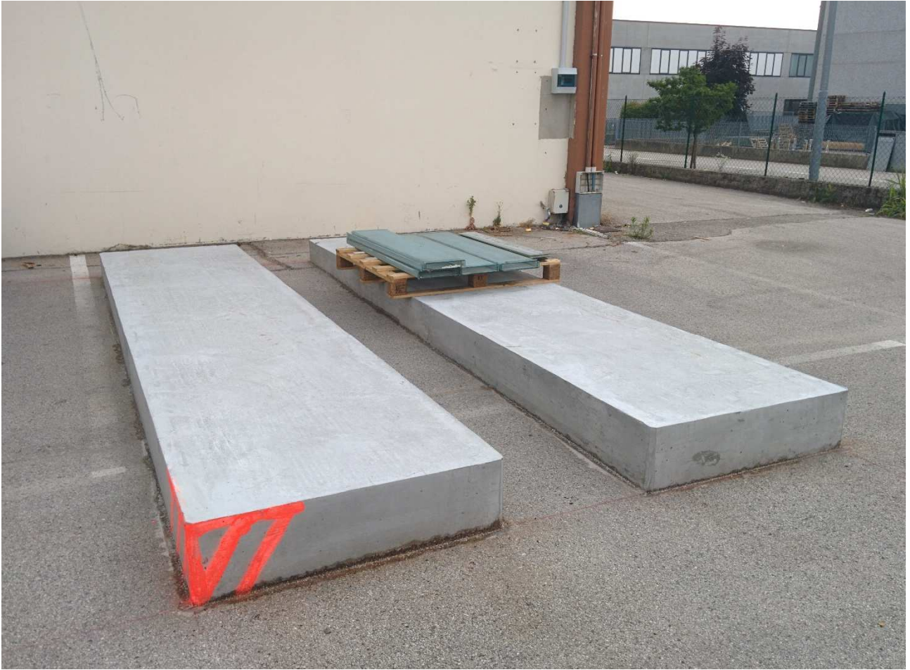
Figura 5.10 Getti in calcestruzzo armato per il sostegno delle macchine frigorifere.
