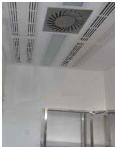
Figura 4.15 Alcuni esempi di terminali di diffusione dell'aria di mandata di un impianto di climatizzazione.
