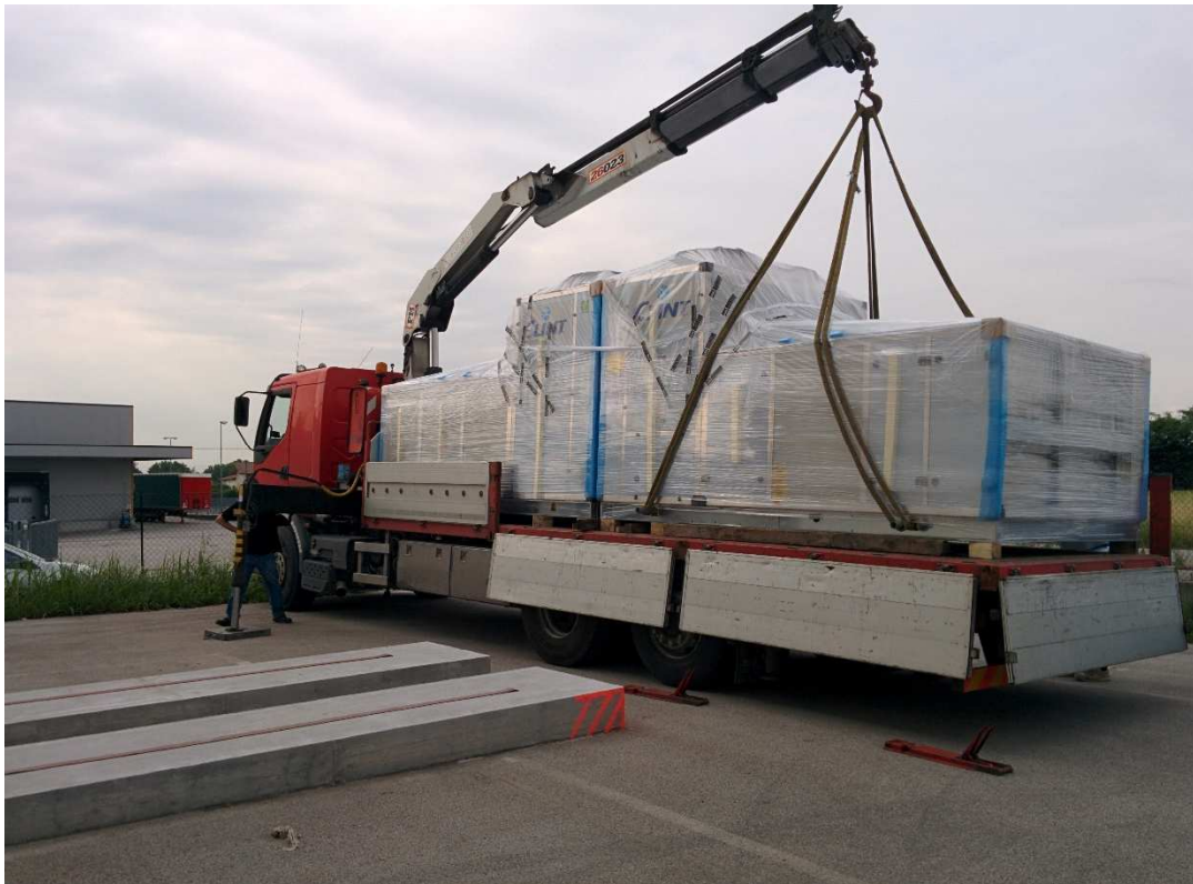
Figura 5.12 Predisposizione delle strisce antivibranti di gomma polimerica sui basamenti in CLS ed aggancio del gruppo frigorifero con il braccio di sollevamento (26/05/2015).
