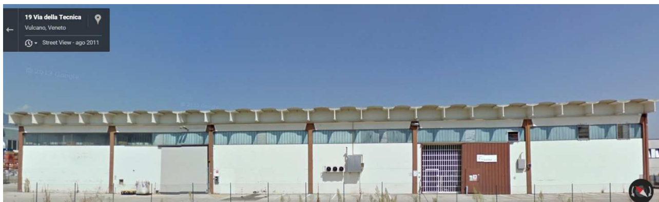
Figura 2.5 Irraggiamento solare lato lungo esposto stabilimento. Foto 08/2011.
