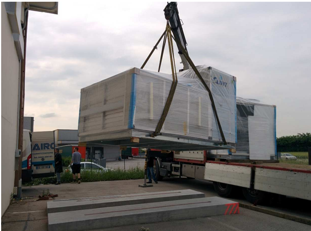
Figura 5.13 Scarico del gruppo frigorifero e successiva posa sui basamenti in CLS (26/05/2015).
