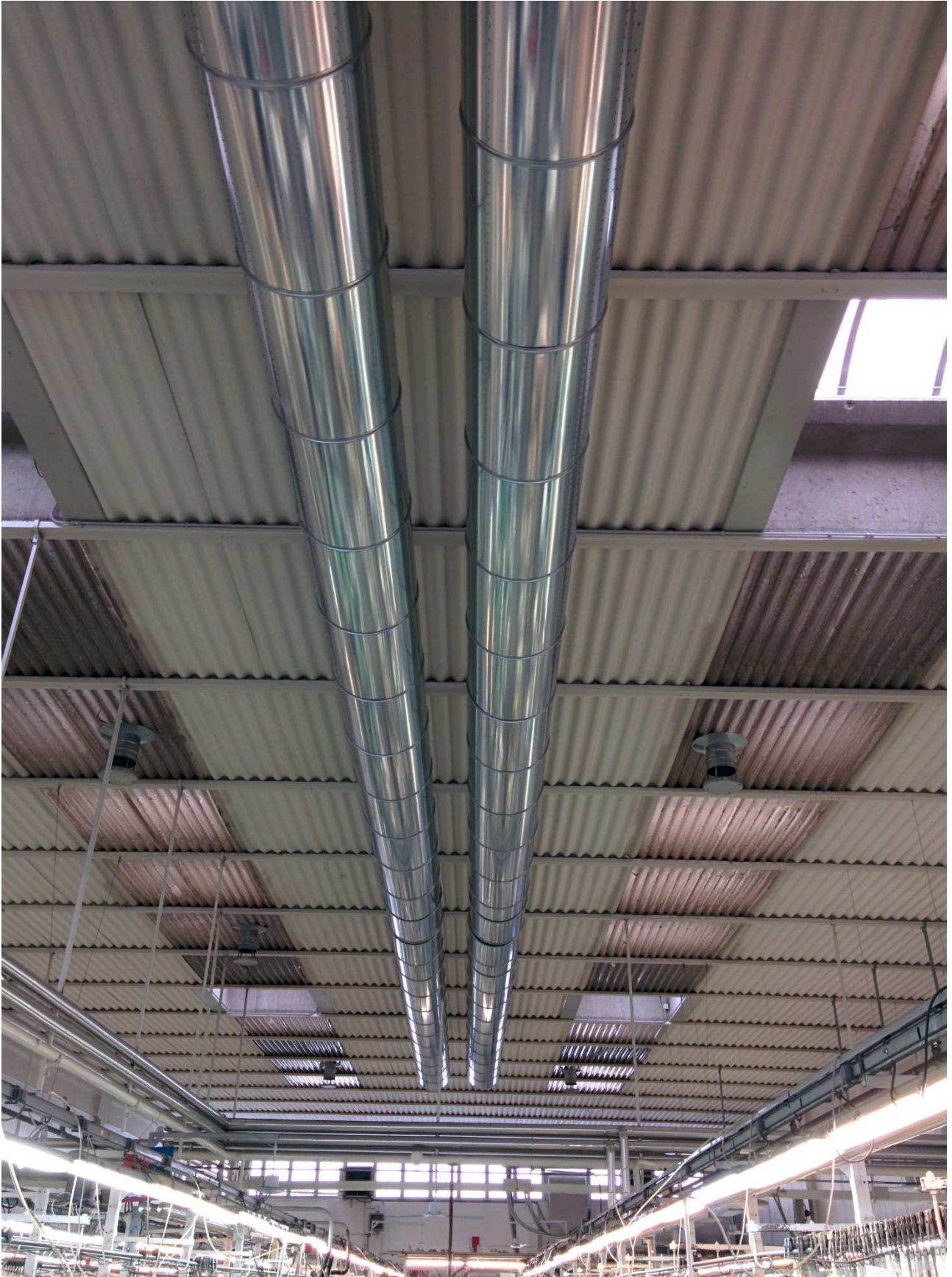
Figura 5.8 Foto rappresentativa dello stato di avanzamento dei lavori (28/04/2015).
