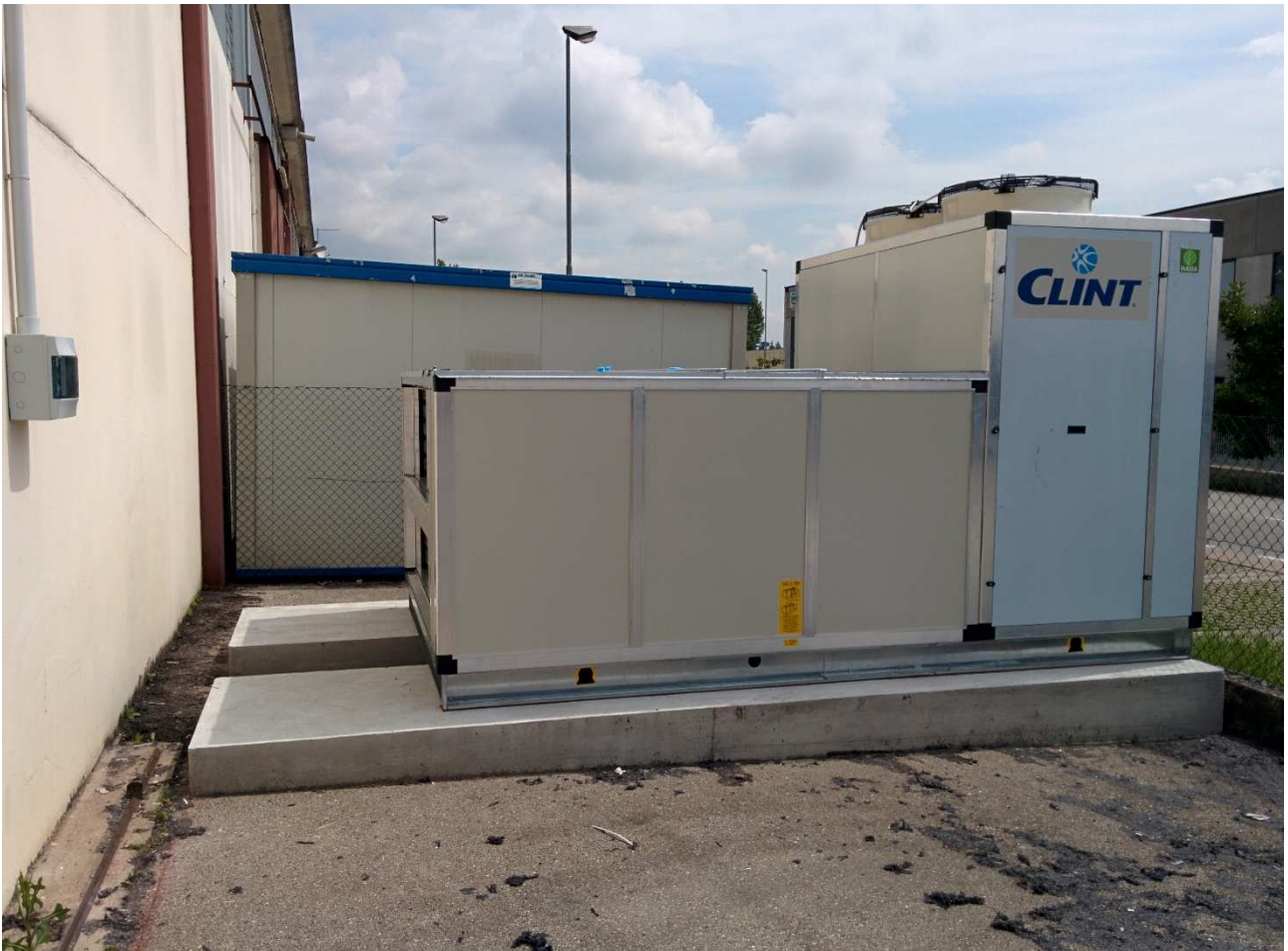
Figura 5.14 Posa completa a misura, di uno dei tre gruppi frigoriferi (26/05/2015).
