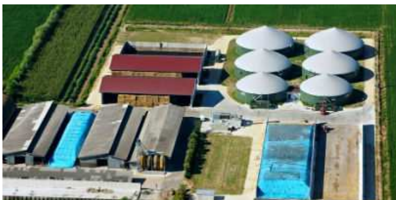
Fig. 8.2 – Impianto di biogas della Stalla Sociale di Monastier (TV) ( www.confcooperativetreviso.it )
