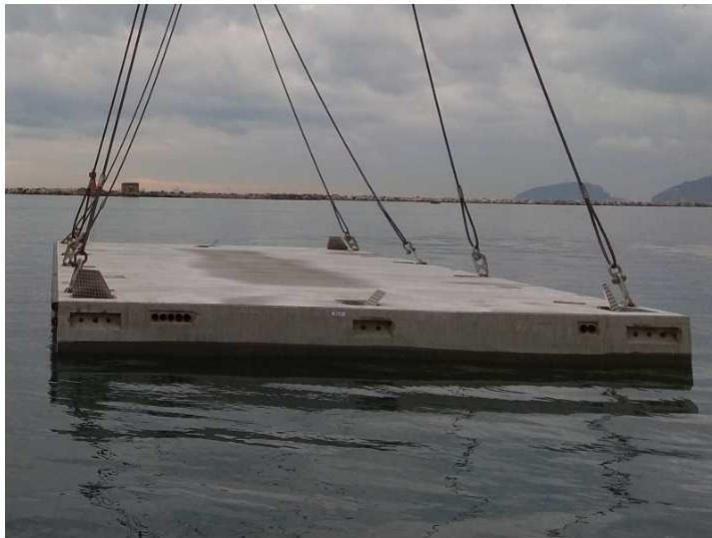
Figura 1.10: Modulo di frangiflutti INGEMAR installato a La Spezia [11]
