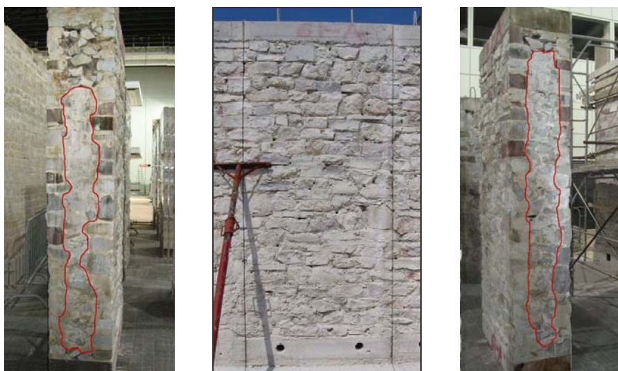
Fig 2.16: Pannello 6I. Rilievo pre-prova: sezione B-B' sx, prospetto frontale, sezione A-A' dx. L'area iniettata è indicata con una polilinea rossa.
