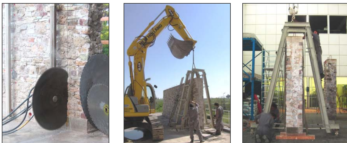
Fig 2.3: Taglio e movimentazione dei pannelli.
