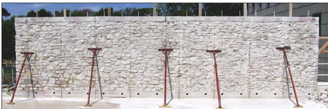
Fig 2.5: Prospetto anteriore del muro completo, a seguito del taglio dei pannelli.
