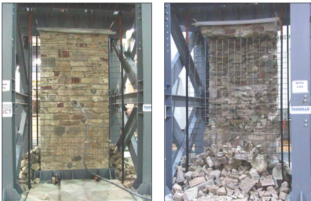
Fig 3.11: Pannello 2-URM. Rilievo fotografico del collasso, 0.25g (fronte-retro).
