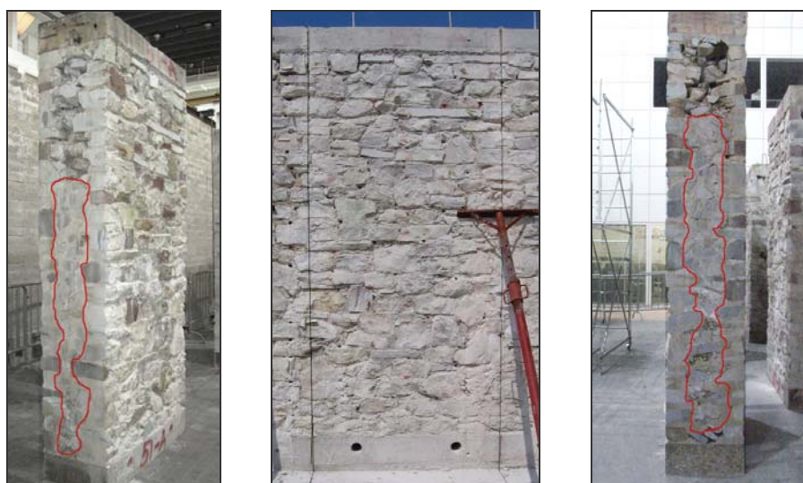
Fig 2.15: Pannello 5I. Rilievo pre-prova: sezione B-B' sx, prospetto frontale, sezione A-A' dx. L'area iniettata è indicata con una polilinea rossa.
