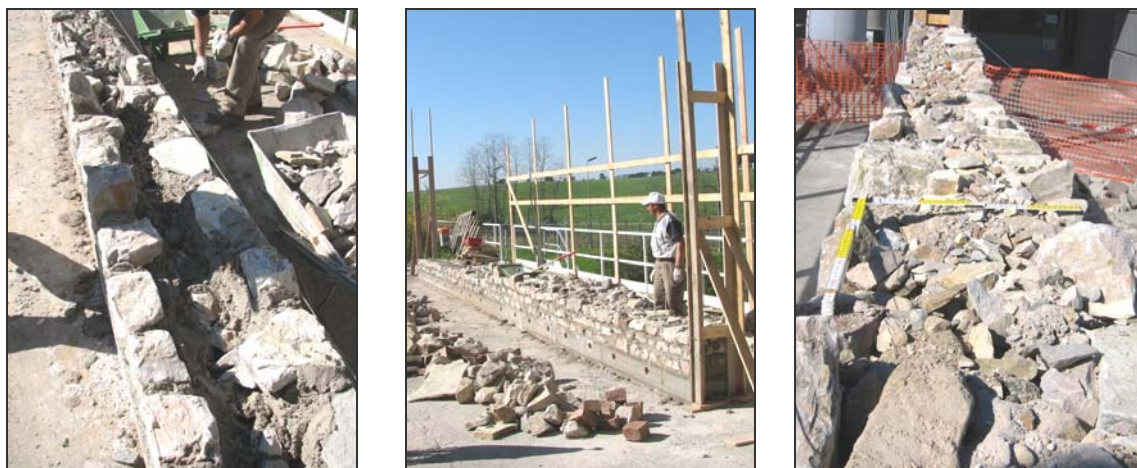
Fig 2.2: Stato di avanzamento con dettaglio della sezione trasversale del muro durante la costruzione.
