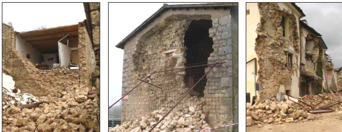
Fig 1.4: Alcuni dei meccanismi fuori-piano di murature multistrato in pietra, osservati nel centro storico di Castelnuovo (AQ) a seguito del sisma del 6 Aprile 2009. [Mazzon, 2010]
