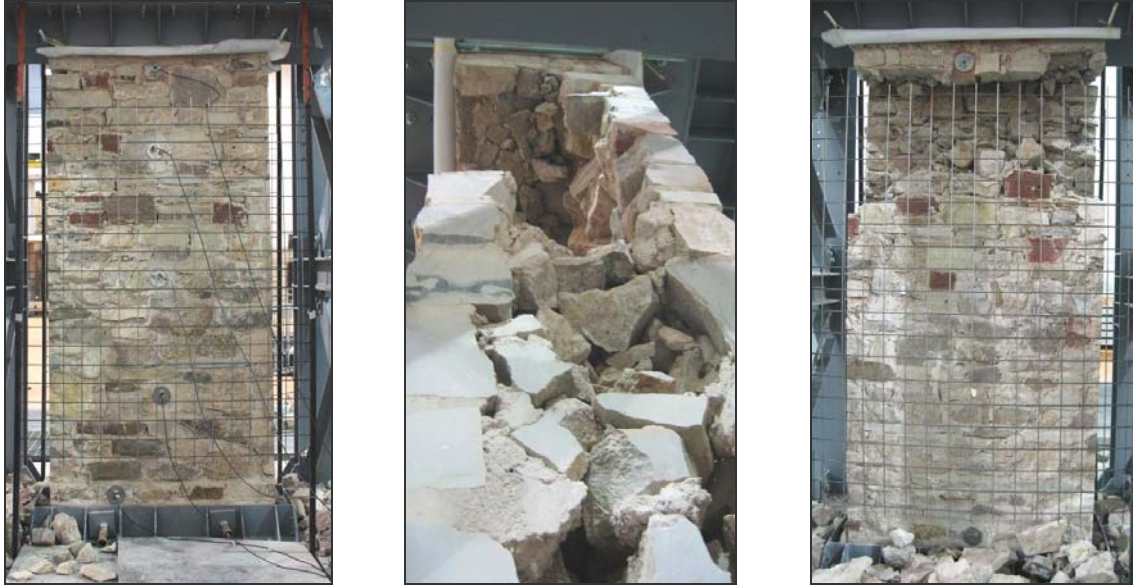
Fig 3.19: Pannello 3T. Rilievo fotografico del collasso, 0.60g (fronte-sezione B-B'-retro).
