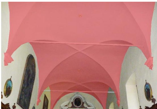
Figura 2.15: Volta a crociera, cappella nord-ovest.
