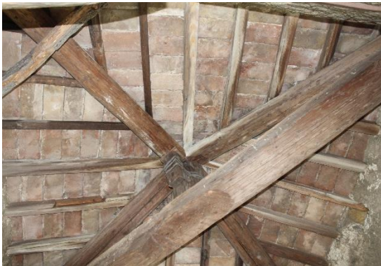
Figura 2.26: Copertura della cella campanaria.
