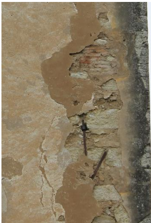
Figura 3.22: Dettaglio del cantonale sud-est del campanile
