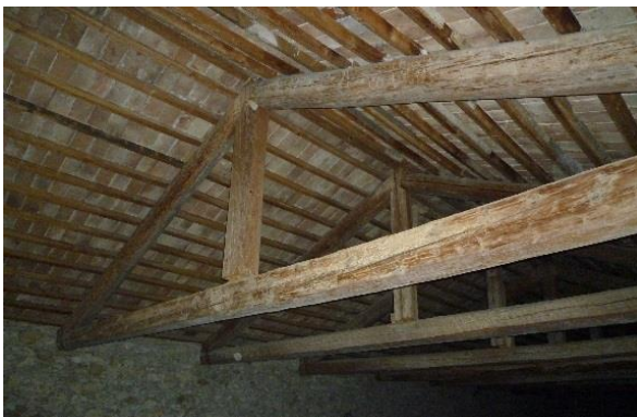
Figura 2.22: Capriate della navata principale.
