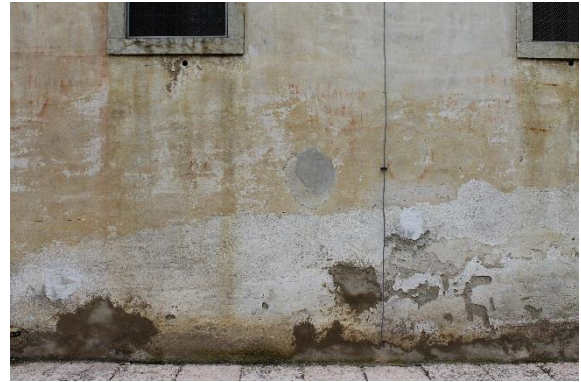
Figura 3.19: Rigonfiamento dell'intonaco
