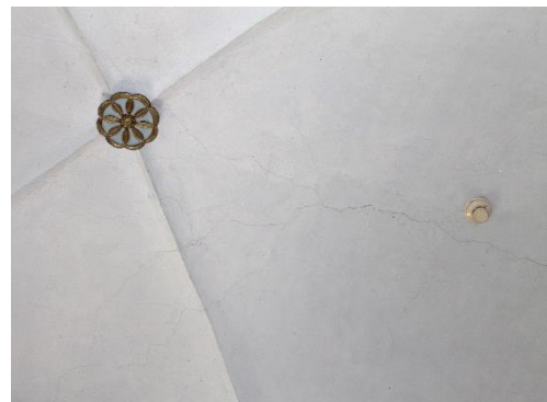
Figura 3.3: Lesioni di interfaccia volta-parete e nelle vele di una volta a crociera.
