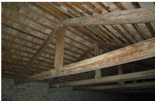
Figura 3.24: Copertura a capriate della navata centrale.
