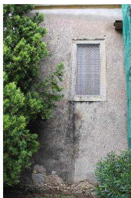
Figura 3.13: Dettaglio della facciata est.
