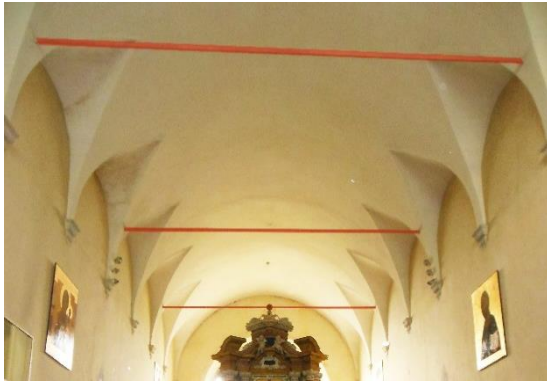
Figura 3.34: Evidenziazione dei tiranti presenti nella navata centrale.
