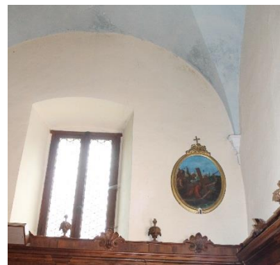
Figura 3.8: Dettagli di alterazioni cromatiche negli intonaci interni.
