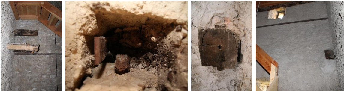
Figura 3.37: Dettagli dei tiranti tagliati nel campanile, nell'ordine lato nord-est, sud-est, sud-ovest.
