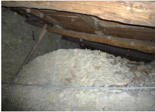
Figura 3.23: Estradosso della volta nord-ovest
