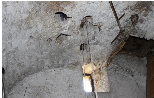
Figura 2.27: Volta a botte di accesso alla cella campanaria.
