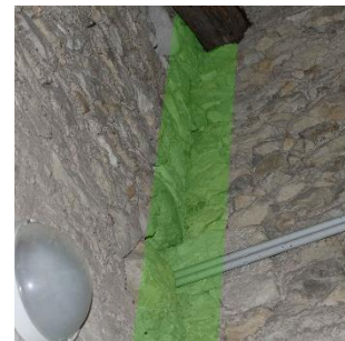
Figura 3.31: accostamento della parete est del campanile alla parete della navata centrale
