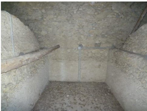
Figura 2.19: Estradosso cappelle nord.
