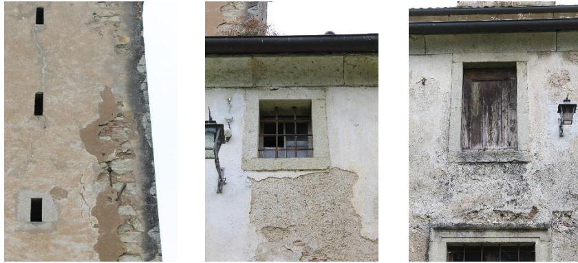
Figura 3.11: Distacco dell'intonaco.
