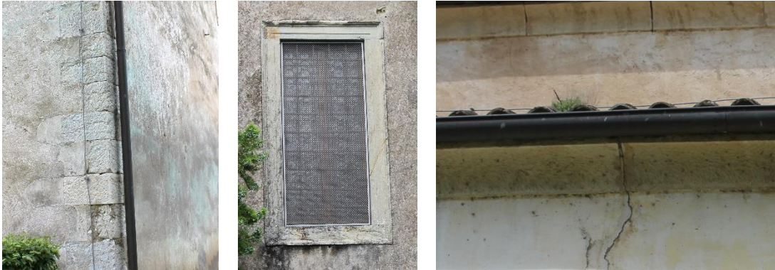
Figura 3.9: Dettagli lapidei delle facciate con tracce di alveolizzazione.
