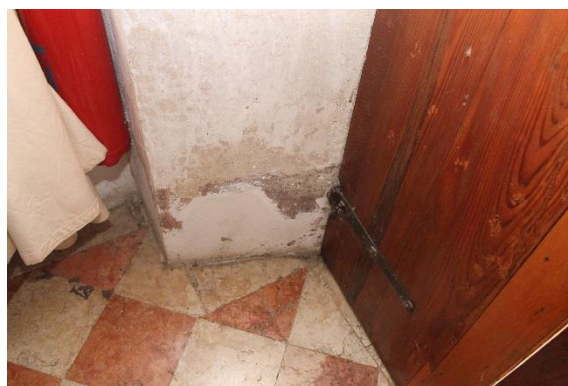
Figura 3.14: Dettaglio dello stipite della porta d'ingresso a sud.
