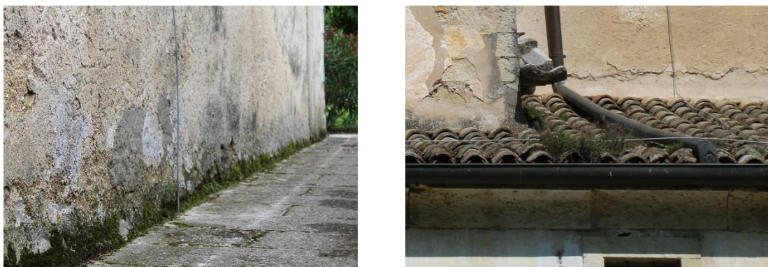
Figura 3.18: Dettaglio del prospetto nord e della copertura dal lato sud.
