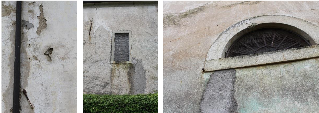
Figura 3.20: Dettagli delle facciate sud, nord e ovest.
