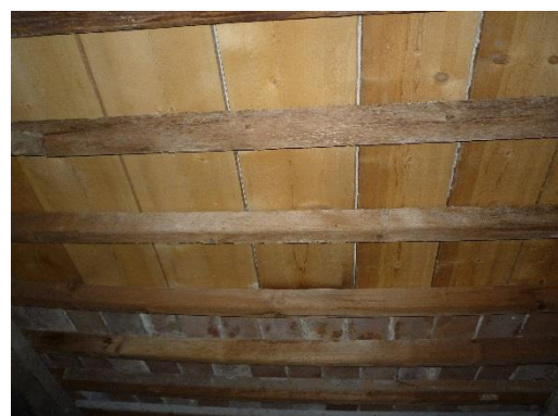
Figura 2.24: Presenza alternata di assi di legno e tavelle nella copertura della navata centrale.
