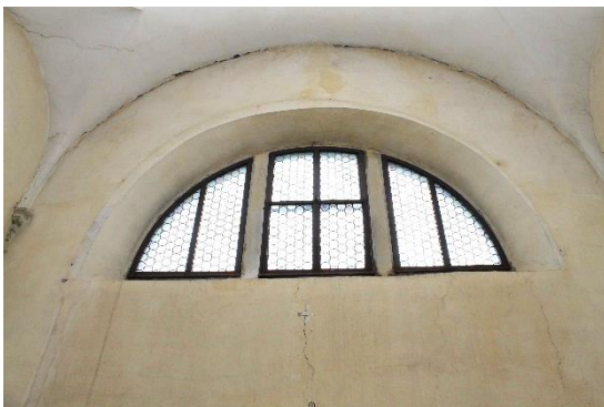
Figura 3.3: Lesioni di interfaccia volta-parete e nelle vele di una volta a crociera.
