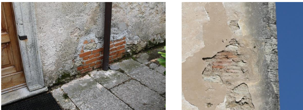
Figura 3.21: Dettagli facciata nord chiesa e sud campanile.
