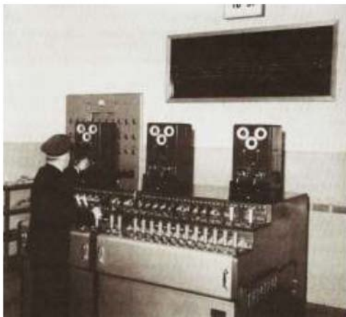
Figura 52 - Banco di manovra di un Apparato Centrale Elettrico a leve singole
