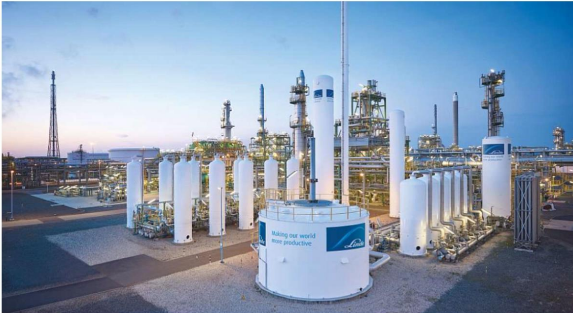
Figura 1.1: Impianto di raffreddamento per idrogeno tipo Linde-Hampson pre-raffreddato, Leuna (Germania) [1]
