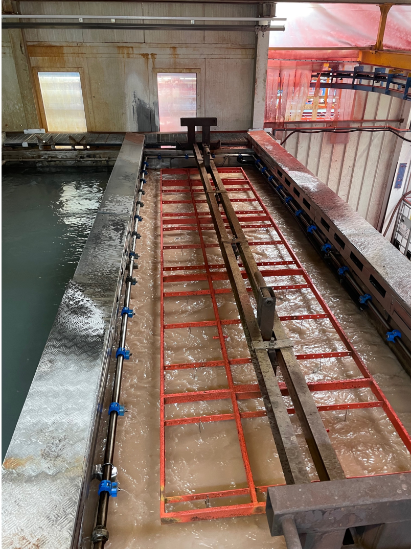
Vasca di sgrassaggio nell'impianto di verniciatura
