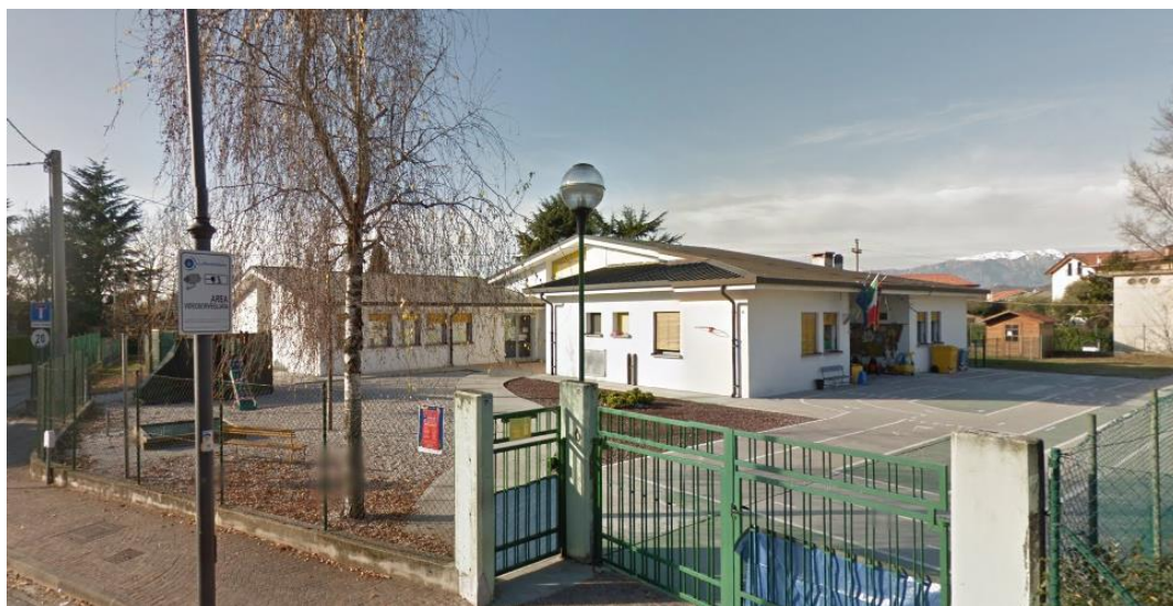
Fig. 48: Veduta esterna Scuola Materna "Menegon" di Montebelluna | Fonte: Google Maps
