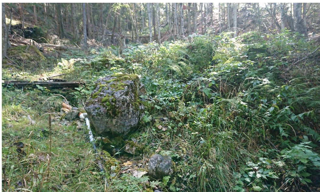
Fig. 3.3.1.1 Dietro al masso è visibile la captazione della sorgente Acqua Fredda, mentre al di sotto di esso si può scorgere il piccolo corso d'acqua che scende lungo il pendio.
