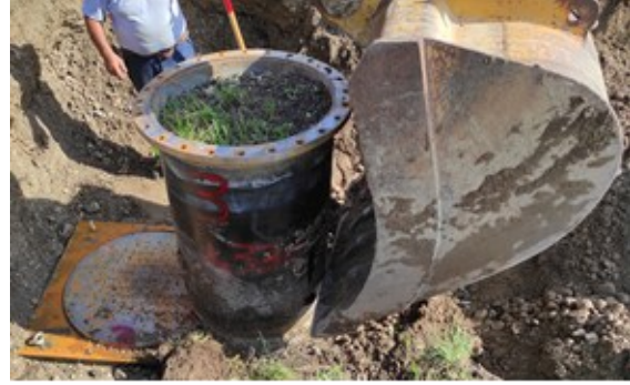
Figura 3.7: posizionamento del cilindro sulla lastra forata.
