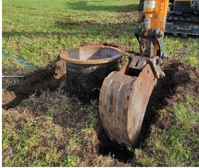
Figura 3.6: inserimento del cilindro nel suolo.
