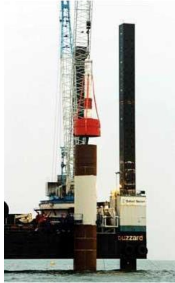
Figura 2.7: Fase di infissione del monopalo tramite battitura.
