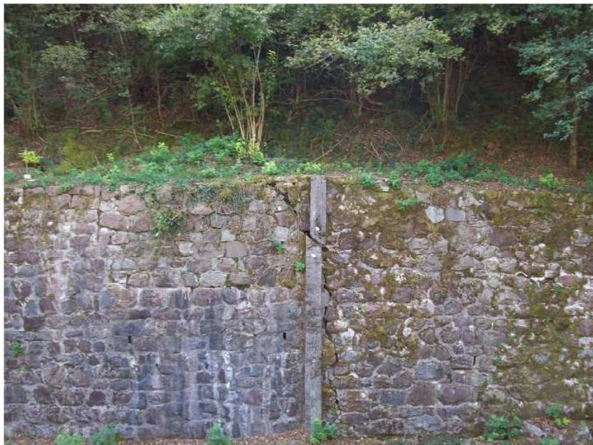
Figura 3.29 – Dettaglio del muro di sponda con visibile una grossa crepa verticale. (Simonini, Giustacchini, Brunori, Cola; 2012)
