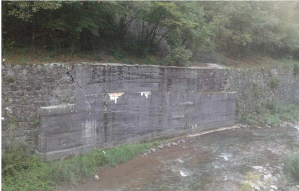
Figura 3.28 – Muro di sponda danneggiato in posizione appena a valle della traversa idraulica.
