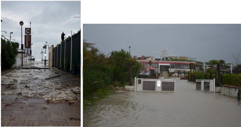
Figura 43 a sx: Strade ed infrastrutture allagate durante l'evento del 11/11/2012 (Fonte https://www.claudiovianello.it/ )
