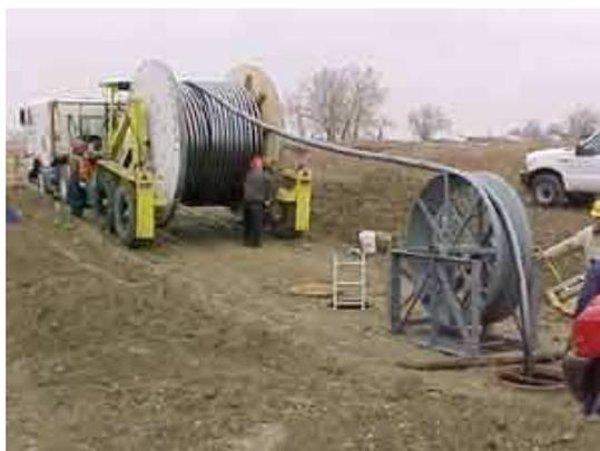
Fig. 1.3.2-2 Operazioni di tiraggio dei cavi
