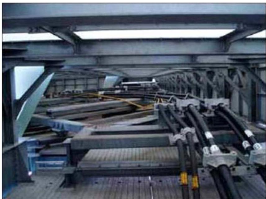
Fig. 1.3.3-10 Cavo posato in strutture che compensano gli spostamenti del ponte
