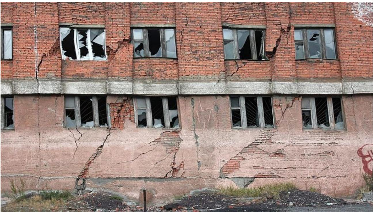
**Fig.3.6.3** Edificio abbandonato in seguito al disgregamento delle fondamenta a Norilsk, in Russia (Alec Luhn, <https://polarjournal.ch/en/2022/01/20/thawing-permafrost-is-undermining-arctic-infrastructure>)
