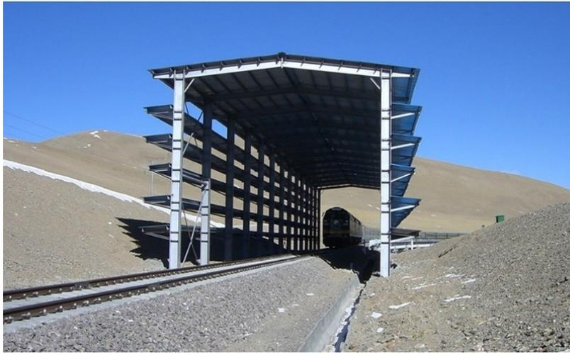
*Fig.3.7.2 Frangisole lungo la linea ferroviaria del Qinghai-Tibet, in Cina (Doré, Niu and Brooks, 2016)*
