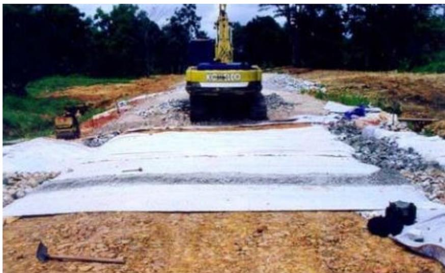
*Fig.3.7.8 Un escavatore effettua un'operazione di prestressaggio su un geotessile (Alfaro, Blatz and Graham, 2006)*
