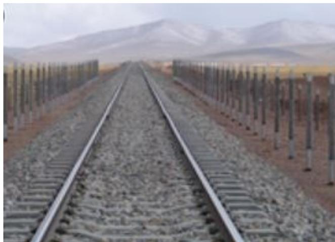
*Fig.3.7.6 Termosifoni a lato della linea ferroviaria Qinghai-Tibet (Doré, Niu and Brooks, 2016)*
