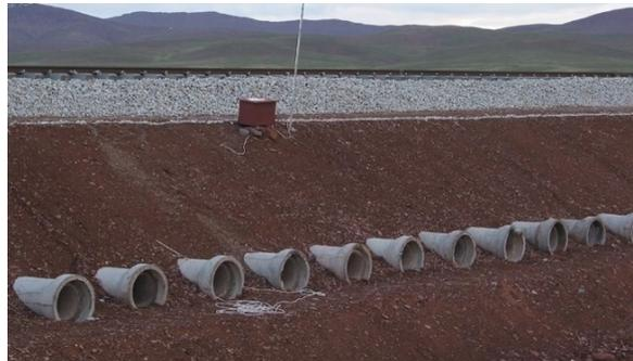
**Fig.3.7.4** Sistema di condotti d'aria aperti lungo la linea ferroviaria del Qinghai-Tibet, in Cina (Doré, Niu and Brooks, 2016)
