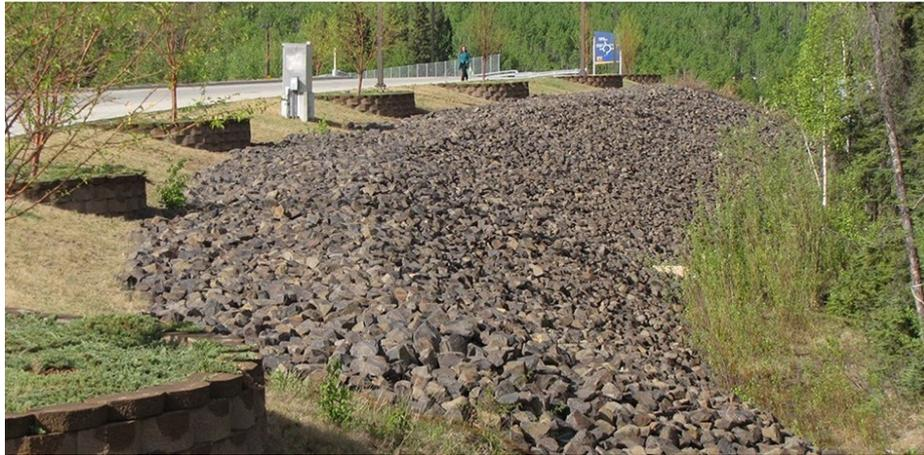
**Fig.3.7.3** Sistema A.C.E. presso Fairbanks, Alaska, U.S.A. (Doré, Niu and Brooks, 2016)
