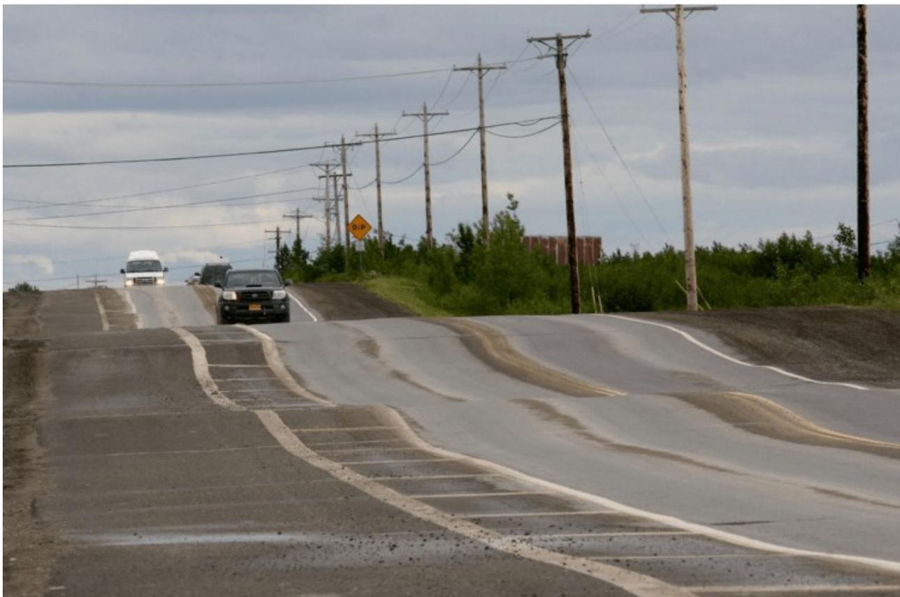
*Fig.3.6.3 Una strada deformata dal disgelo del permafrost in Alaska*
