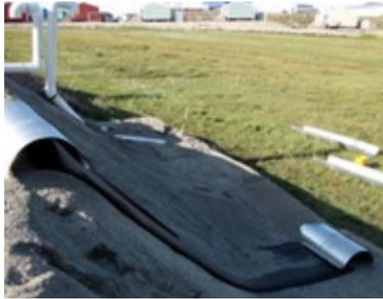
*Fig.3.7.5 Drenaggi di calore in costruzione sulla strada d'accesso all'aeroporto di Salluit, in Quebec (Canada) (Doré, Niu and Brooks, 2016)*
