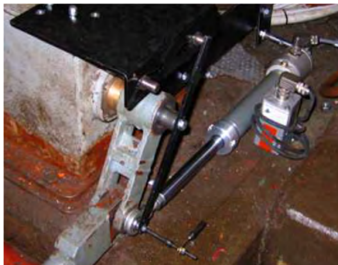
Figura 7. 13 LVDT installato sul distributore della turbina. Fonte [7]
