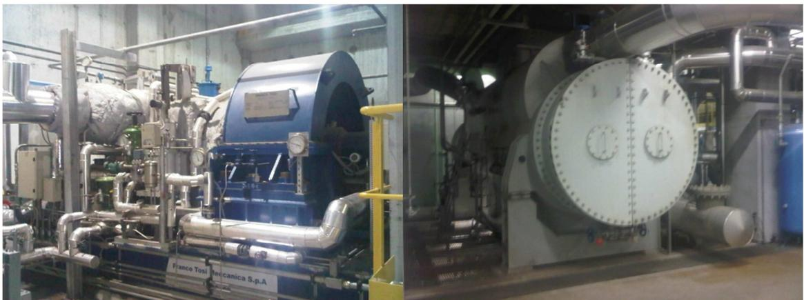
Figura 1.1.4.1: Turbina e condensatore
