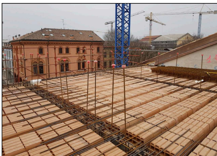
Figura 10: Solaio in latero-cemento
