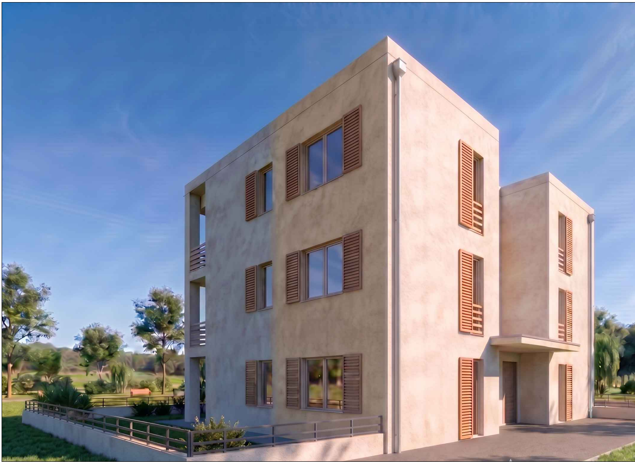
VISTA DELL'EDIFICIO DAL VIALETTO D'INGRESSO A NORD-EST
