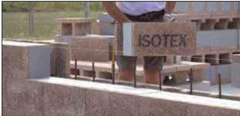
Figura 11: Muratura con Blocco cassero Isotex
