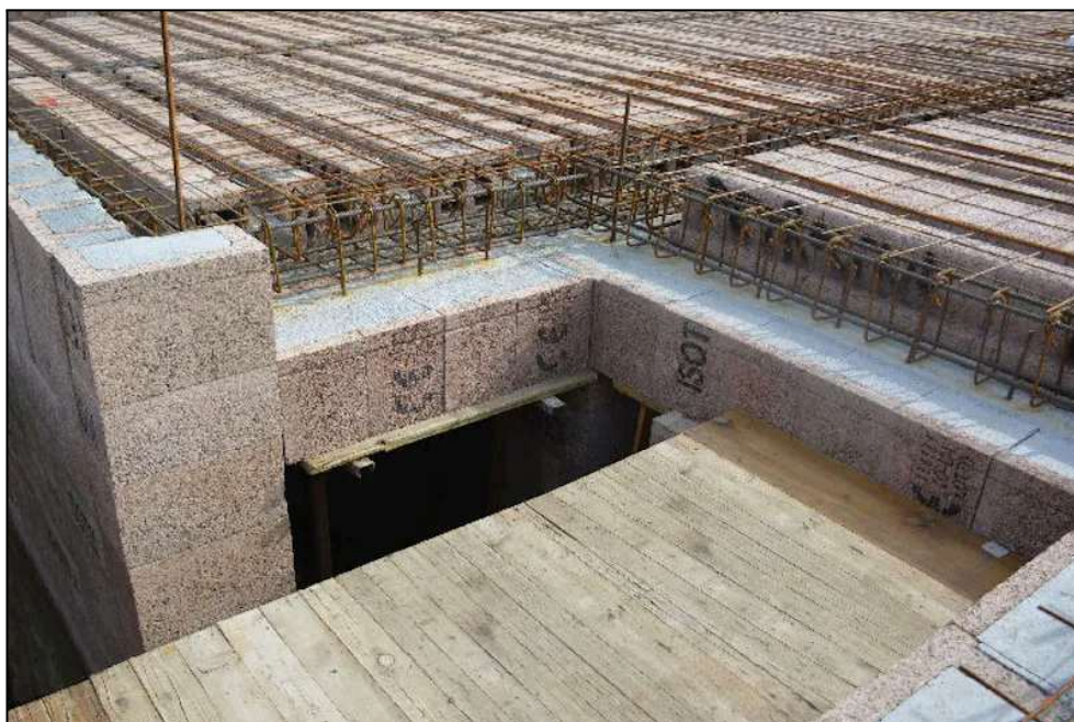
Figura 12: Esempio solaio con Blocco cassero Isotex
