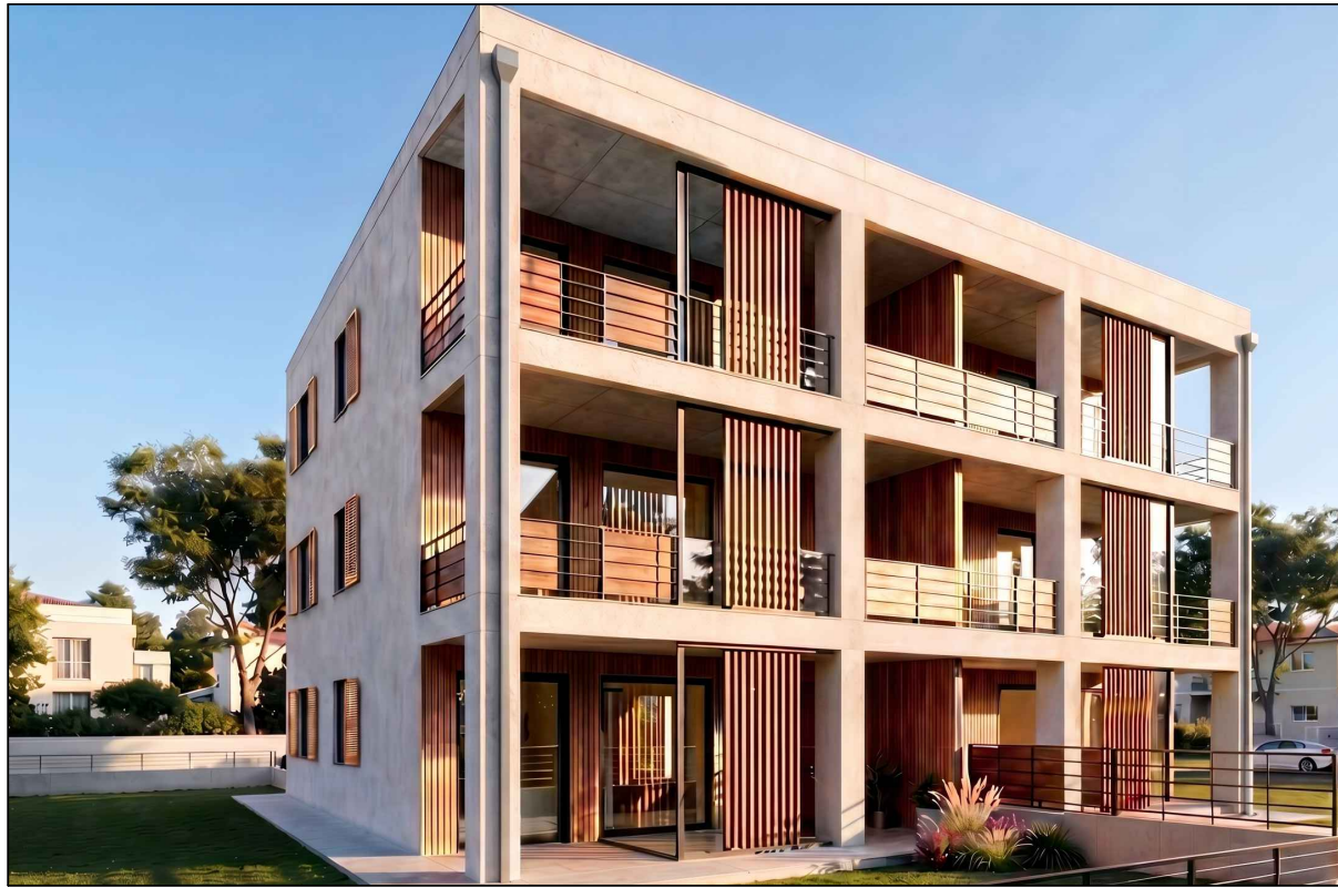
VISTA DELL'EDIFICIO DAL GIARDINO PRIVATO A SUD-OVEST
