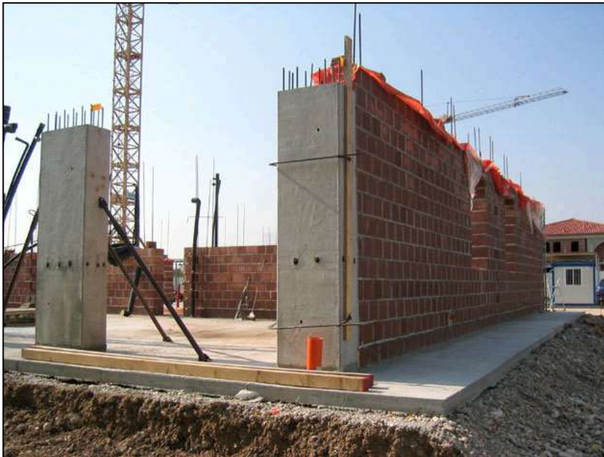
Figura 8: Muratura in laterizio e telaio in C.A
